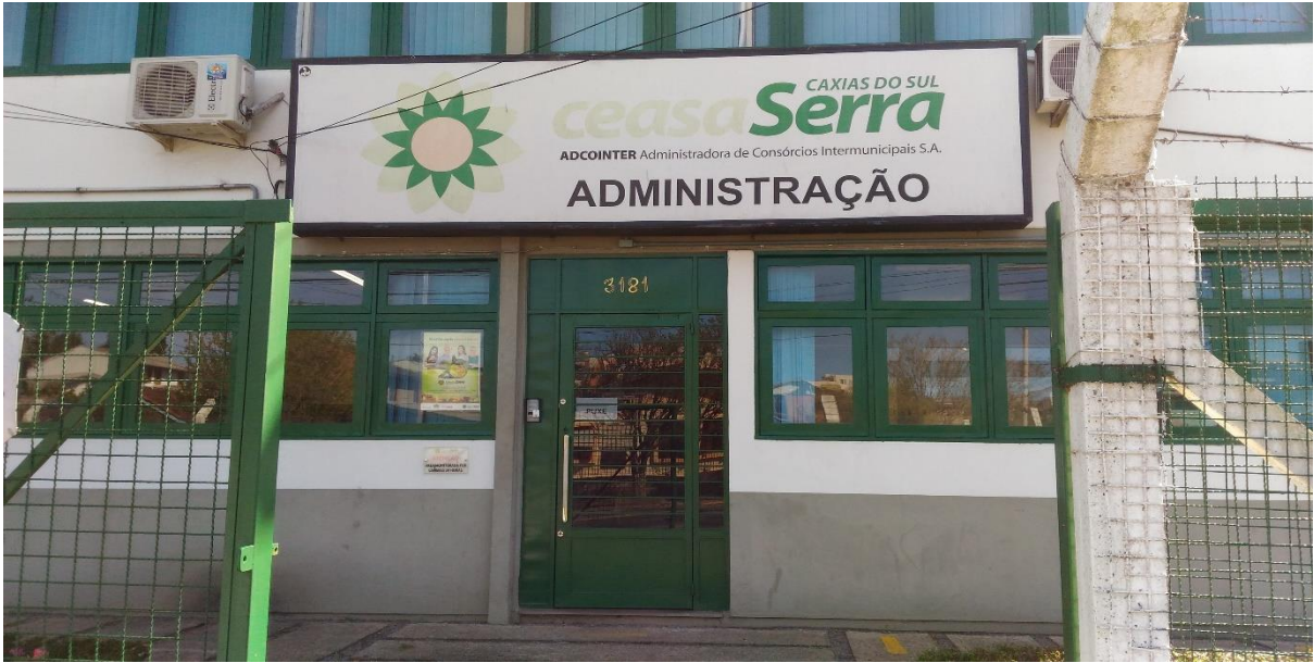
Figura 10 - Sede administrativa CEASA Serra.
