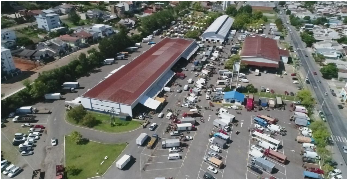
Figura 1- Pavilhão dos produtores (telhado branco), estrutura dos boxistas (na parte central do terreno) e administração, com telhado bordô).
