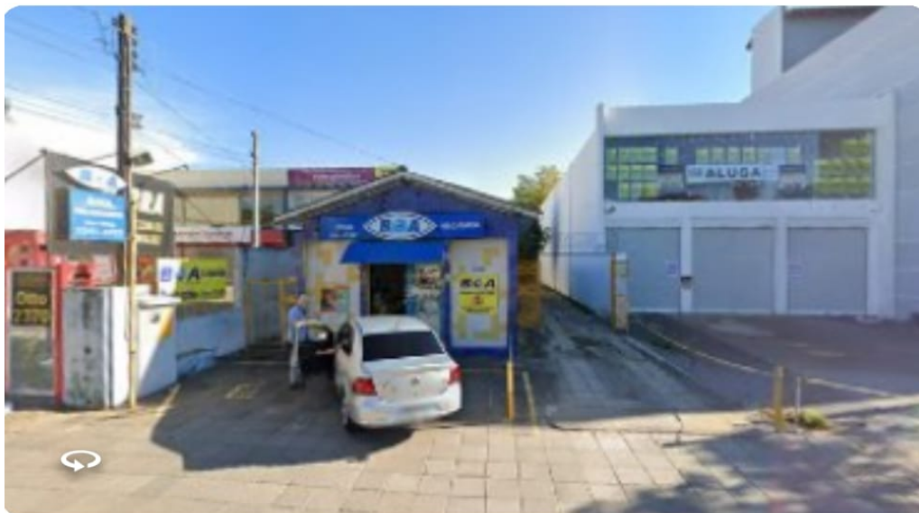
Figura 63 - A frente da casa da Otto. Atrás, o pátio ainda é cheio de árvores
