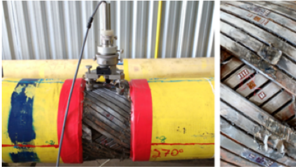
Figura 20 - Ensaio com o MFC para a determinação da tensão efetiva. (a) Visão geral do equipamento montado na amostra e (b) detalhe da janela aberta para acesso à armadura interna.
