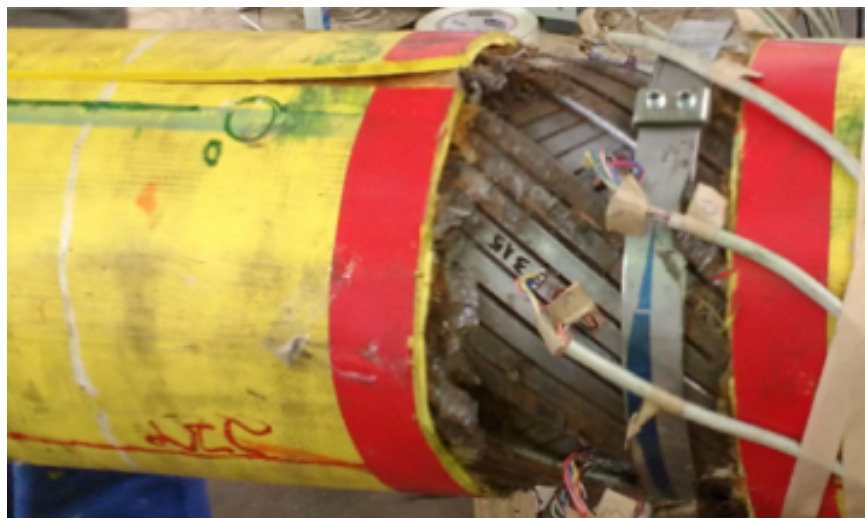
Figura 23 – Corte para remoção da capa externa.
