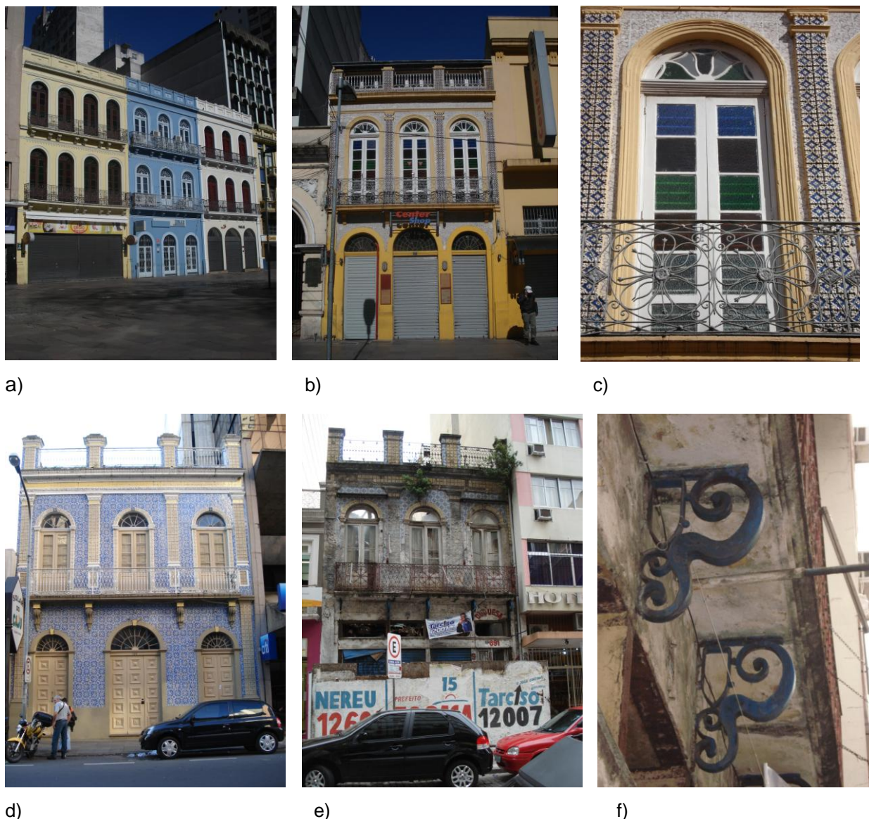
Figura 3.80 – Edificações com elementos da arquitetura neoclássica no centro histórico de Porto Alegre: a) conjunto de 3 prédios da Rua Dr. José Montauray, 155, 159 e 167; b) sobrado da Rua José Montauray n° 121, que teve o 3° pavimento descaracterizado; c) detalhes do 2° pavimento – esquadria com arco pleno e bandeira de vidros coloridos, ombreiras de argamassa, gradil de ferro na sacada corrida; d) sobrado da Rua 7 de Setembro, n° 708; e) sobrado da Rua dos Andradas, n° 895, em ruínas; f) detalhe das mãos francesas que sustentam a sacada corrida. Fonte: fotografias da autora.
