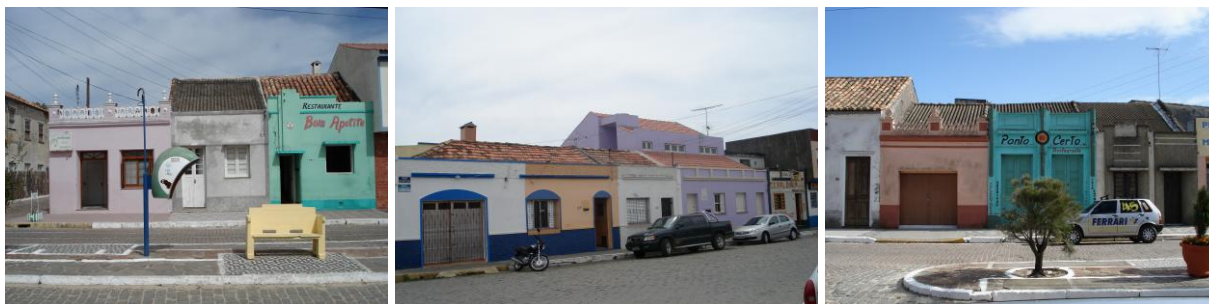
Figura 3.63 – Exemplos de casas térreas em fita, conhecidas como porta-e-janela. Fonte: fotografias da autora.
