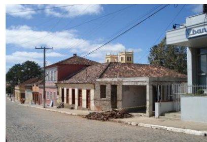
Figura 3.34– Construção em execução ao lado da Casa de Garibaldi.
