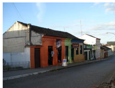
Figura 3.47 - Edificação pintada com duas cores e fortes.
