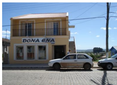
Figura 3.32 – Edificação contemporânea Fonte: fotografias da autora
