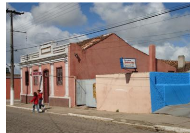
Figura 3.38 - Vista lateral do hotel
