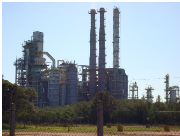
Figura 7: Usina Termelétrica Sepé Tiarajú (Foto: Márcia Frank de Rodrigues)
