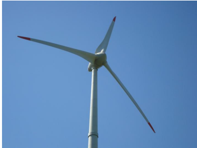
Figura 14: Aerogerador (Foto: Márcia Frank de Rodrigues)
