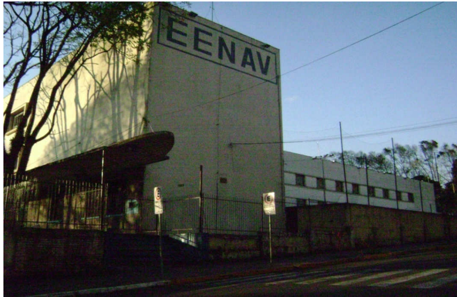
Figura 4 - Foto da fachada da EENAV
