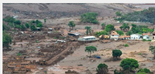
Mariana's dam collapse (Minas Gerais, Brazil) 2015 | Agência Brasil Photo / Antônio Cruz
