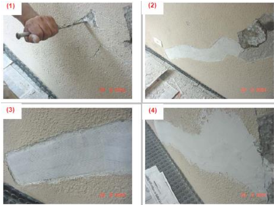
Figura 21 – (1) Abertura ao longo da fissura; (2) preenchimento do sulco formado com massa acrílica; (3) aplicação de tela de poliéster com bandagem central; (4) 2ª demão de massa acrílica, pronta para receber o acabamento final.
