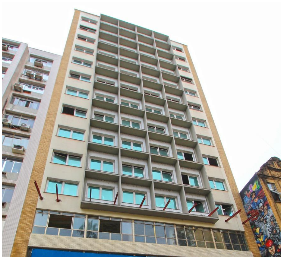
Figura 56 - Aspecto atual da fachada oeste.
