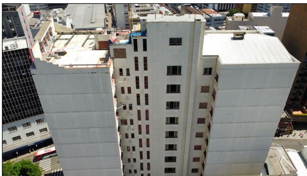
Figura 48 - Aspecto atual da fachada sul.
