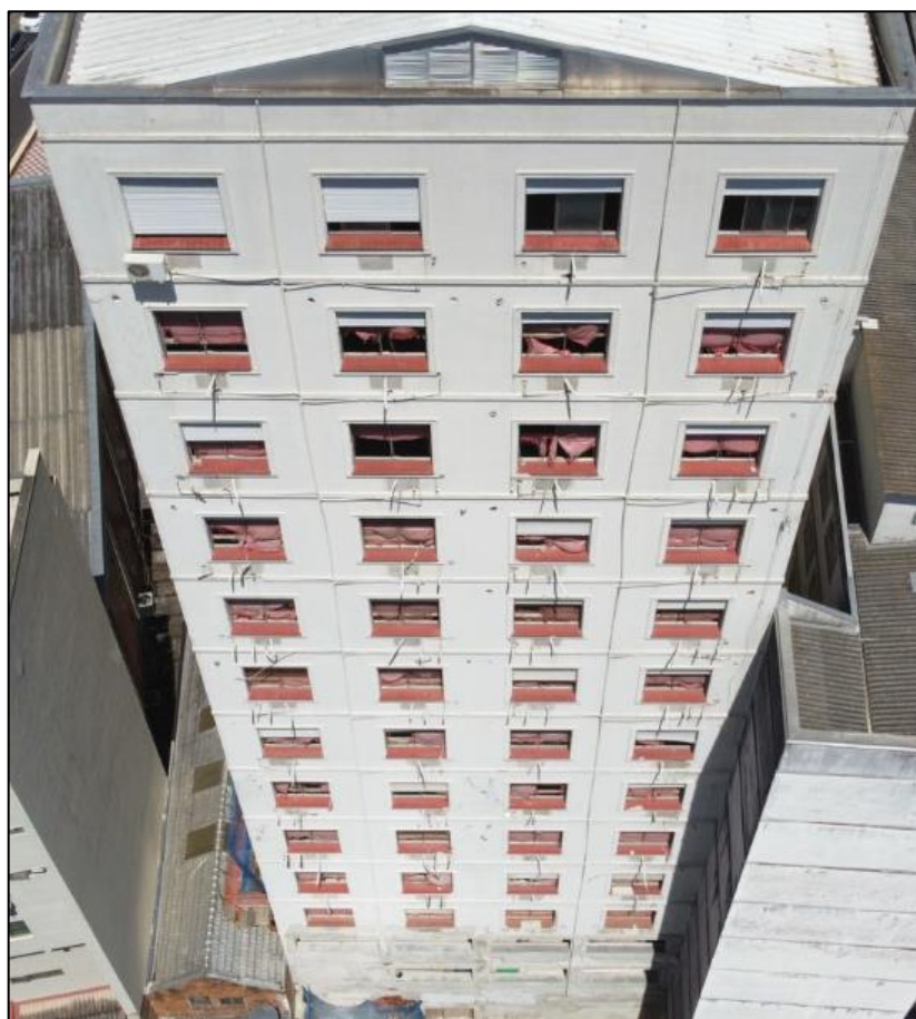
Figura 59 - Aspecto atual da fachada leste.
