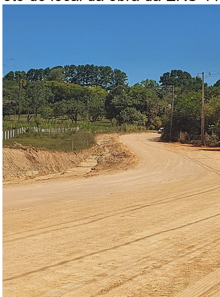
Figura 6 - Foto do local da obra da ERS-118 no KM 43.
