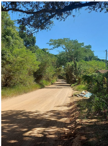
Figura 5 - Foto da ERS-118 no KM 50, situação atual.
