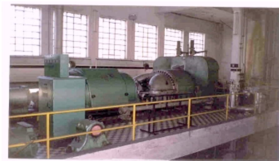
Figura 7.13 – Modelo de turbina de condensação de usina de médio porte (fonte: CGTEE)
