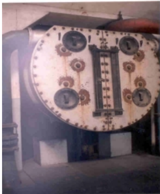
Figura 7.2 – Condensador típico de uma central térmica de médio porte
