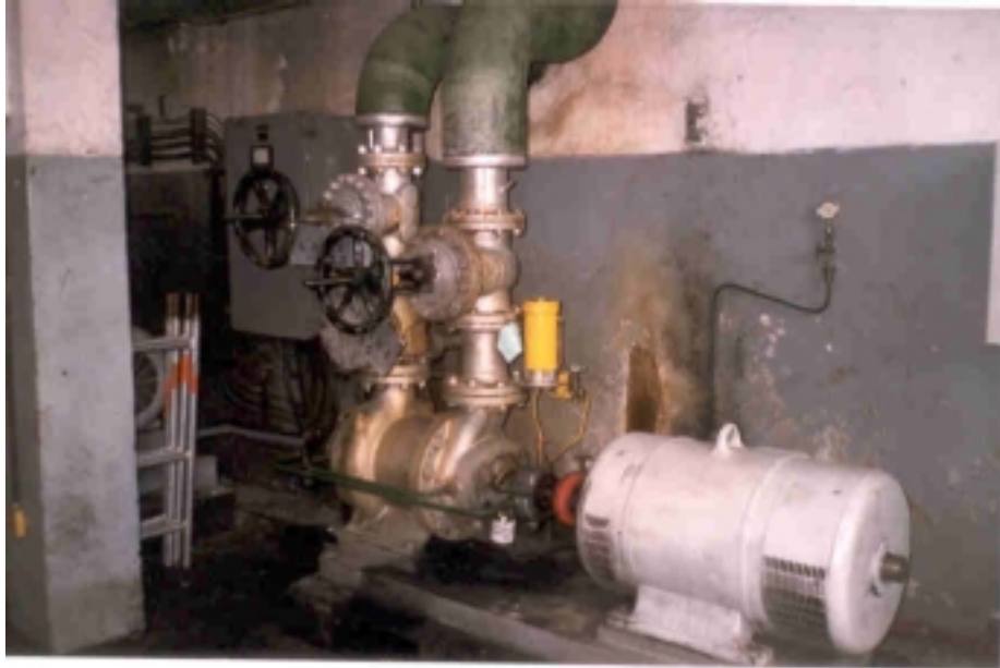
Figura 7.5 – Bombas de alimentação de um gerador de vapor de uma central termelétrica de médio porte (fonte: CGTEE)
