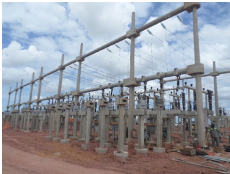
Figura 10 – Exemplos de barramento flexíveis.
