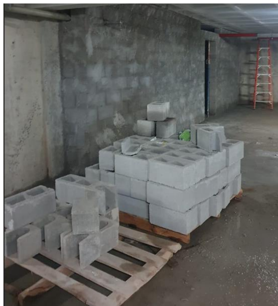
Figura 14: alvenaria finalizada com sobra de material
