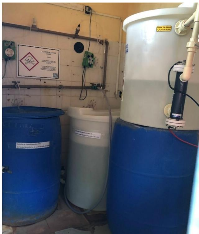
*Figura 20. Sistema de desinfecção e fluoretação das águas da CORSAN no município de São Pedro do Sul. Fotografia da autora.*
