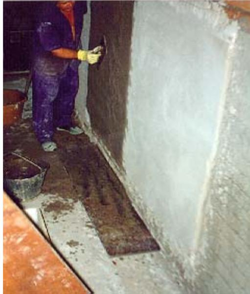
FIGURA 3.10 – Execução dos painéis de revestimento em argamassa
