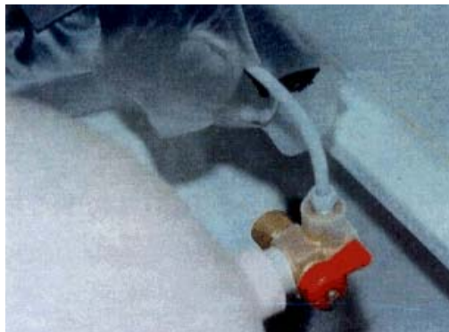
Figura 8.2 – Instalação da válvula de cilindro
