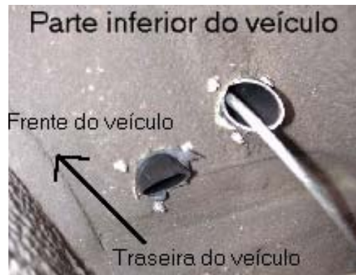
Figura 8.3 - Instalação do sistema de venteio
