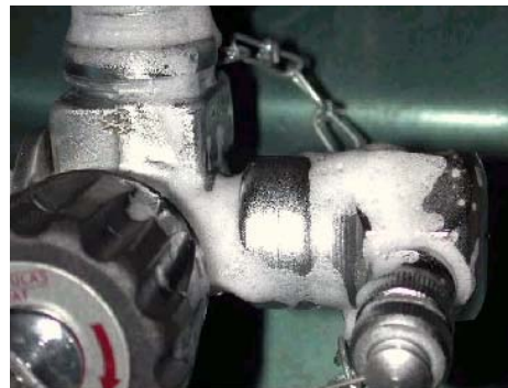
Figura 8.4 - Verificação de vazamentos em válvulas e conexões
