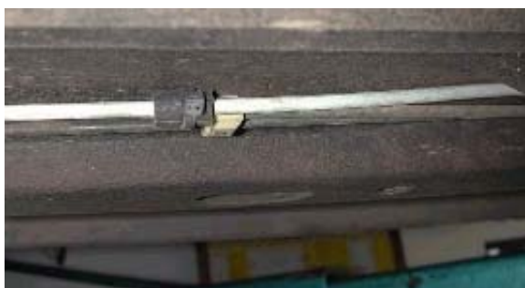
Figura 8.8 - Instalação da tubulação de alta pressão
