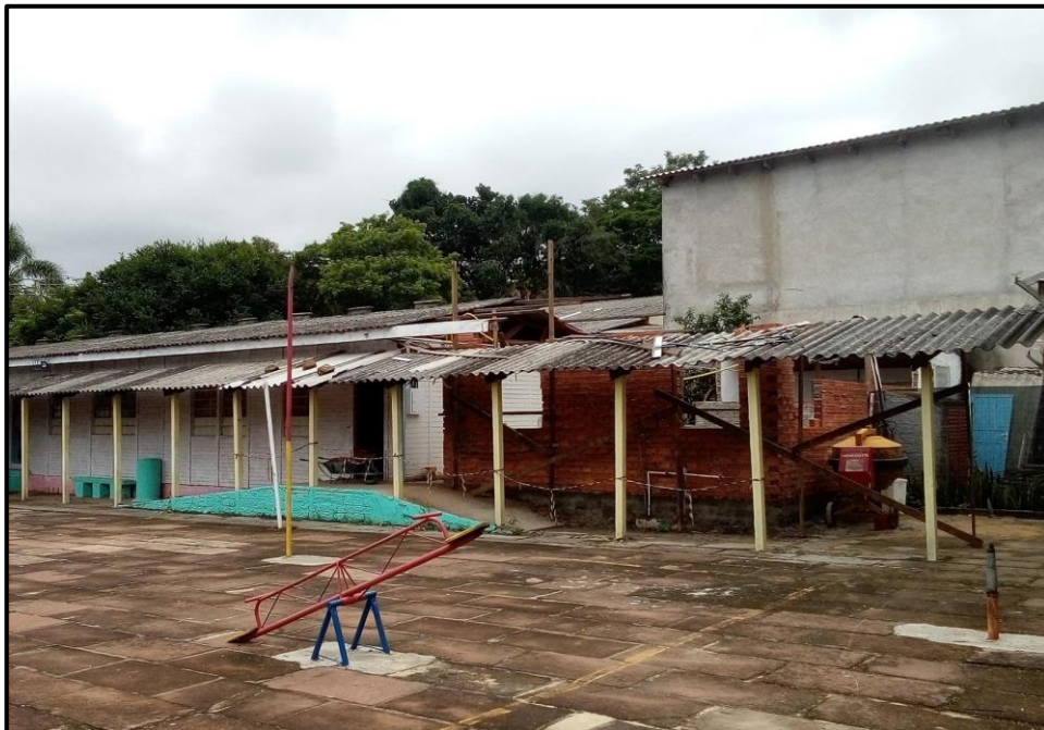
Figura 9: Construção do refeitório
