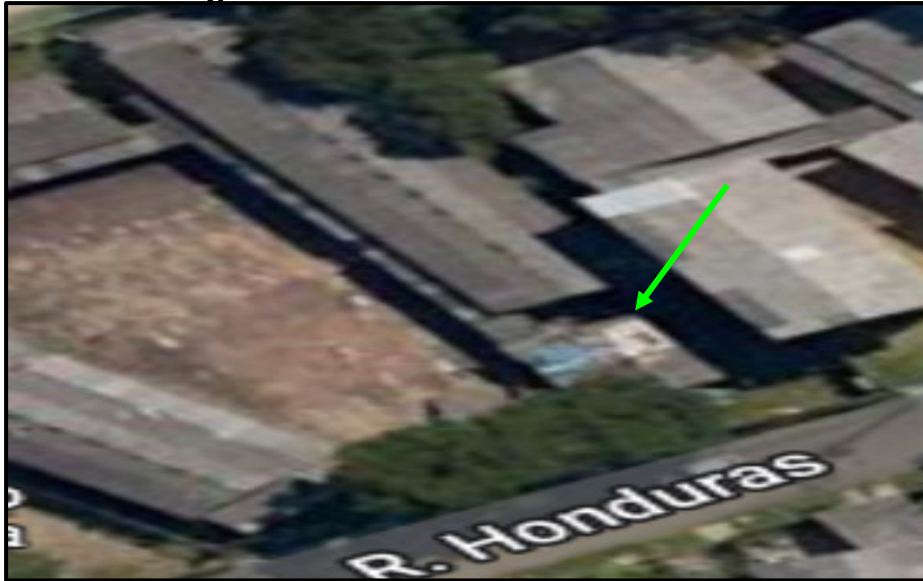
Figura 2: Telhado da Escola Luiz Gama
