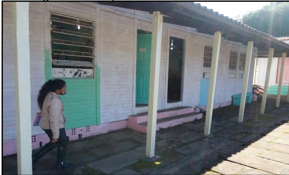
Figura 5: Testes para as cores das salas de aulas
