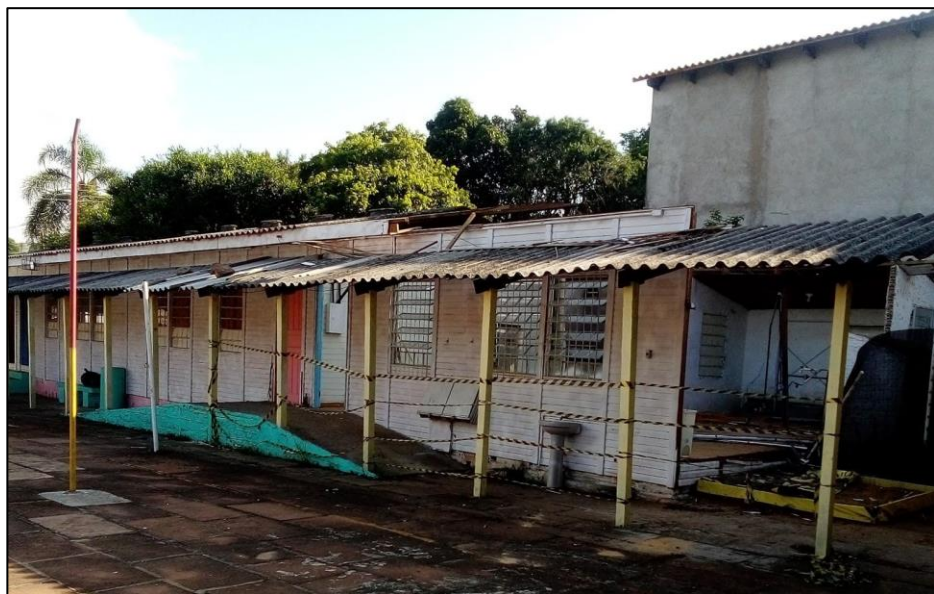
Figura 4: Reforma do Refeitório da Escola
