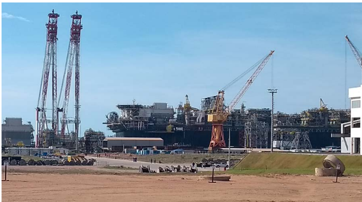
Figura 2 – Plataforma FPSO Petrobras P-68 em fabricação – Estaleiro Jurong – Aracruz (ES)
