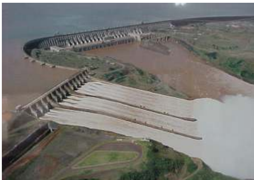
Figura 3: Barragem de Itaipu (BRASIL, 2008)
