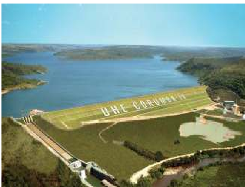
Figura 9: Barragem de Corumbá IV (COMPANHIA ENERGÉTICA DE BRASÍLIA, 2006)
