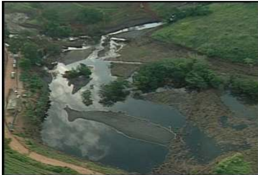
Figura 6: barragem de resíduos industriais de Cataguases MG (TV Panorama, 2008)
