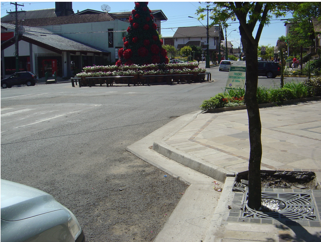
Figura 38: rotatória e extensão de calçada na avenida Borges de Medeiros
