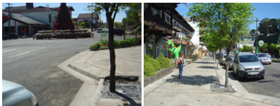
Figura 16: extensão de meio fio, adequação da calçada e do mobiliário
