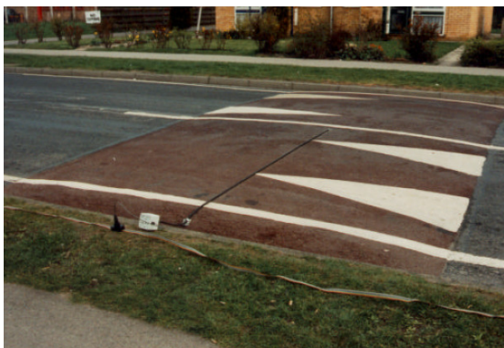
Figura 14: ondulações (BELO HORIZONTE, 1999)
