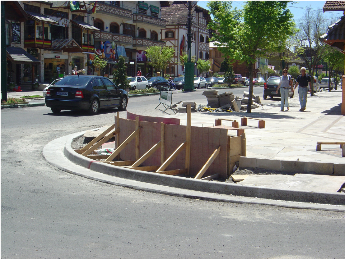
Figura 31: obras na avenida Borges de Medeiros
