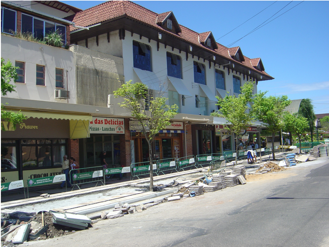
Figura 35: obras na avenida Borges de Medeiros
