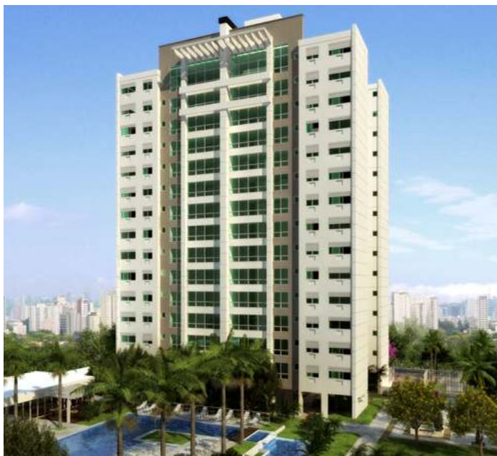
Figura 8: Obra B fachada torre 1 (trabalho não publicado) 11
