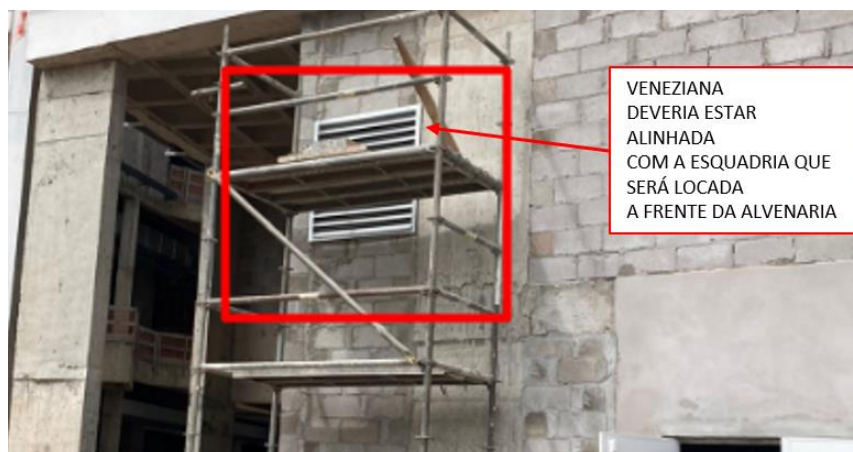
Figura 58 – Execução de veneziana (Trecho 07)
