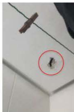
Imagem 78 – Dano ocorrido no forro de gesso da área de serviço possivelmente relacionado à infiltração
