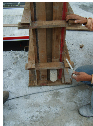
Figura 13: verificação do prumo
