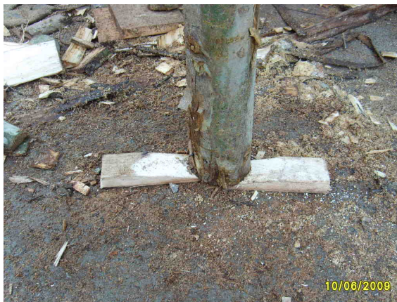
Figura 7: detalhe das cunhas de madeira
