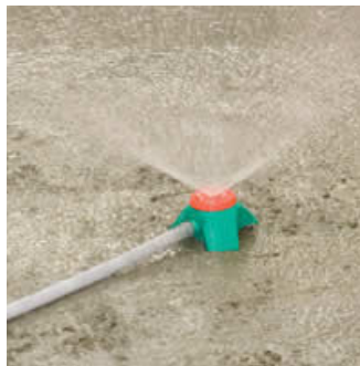
Figura 6: cura úmida por aspersão (REPETTE, 2006, p. 21)
