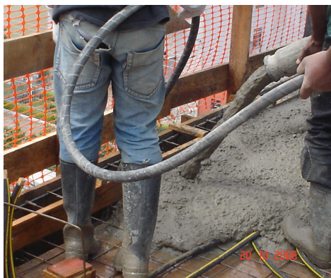
Figura 10: lançamento e adensamento do concreto
