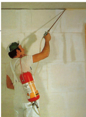
Figura 4: encunhamento com aplicação da espuma de poliuretano (SABBATINI, 2002)
