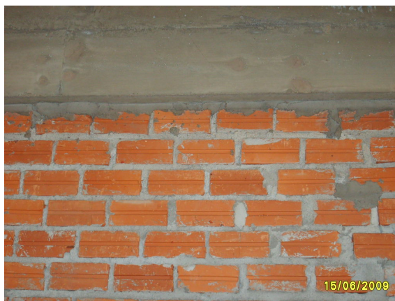
Figura 3: preenchimento com argamassa expansiva
