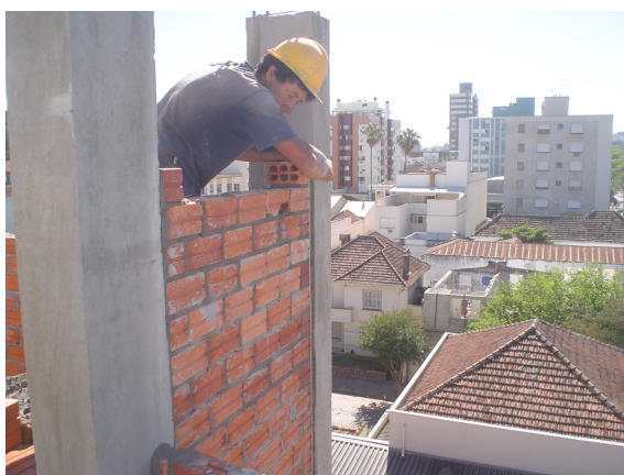
Figura 15: verificação do prumo da parede
