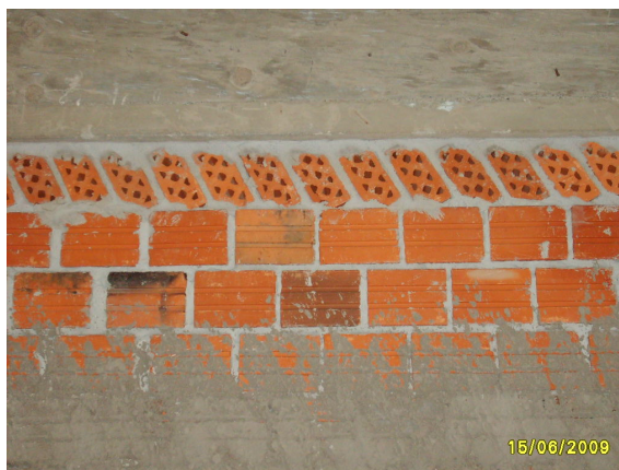
Figura 2: encunhamento com componentes cerâmicos
