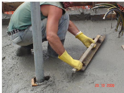
Figura 11: nivelamento da laje
