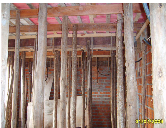
Figura 8: escoramento em madeira
