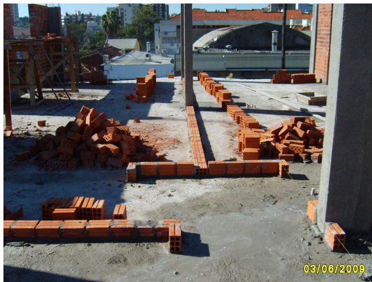
Figura 14: marcação e assentamento de blocos da primeira fiada da alvenaria
