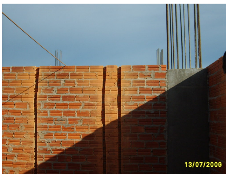
Figura 20: canaletas para passagem das tubulações elétricas
