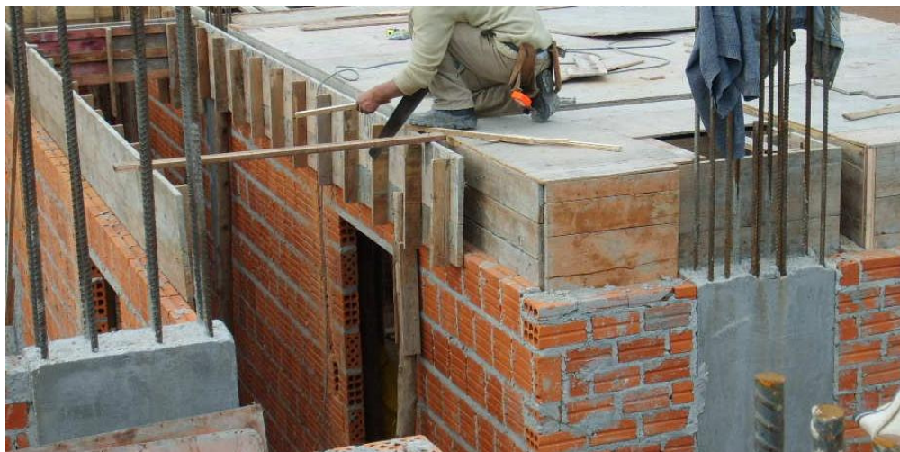
Figura 19: fôrmas de vigas e laje
