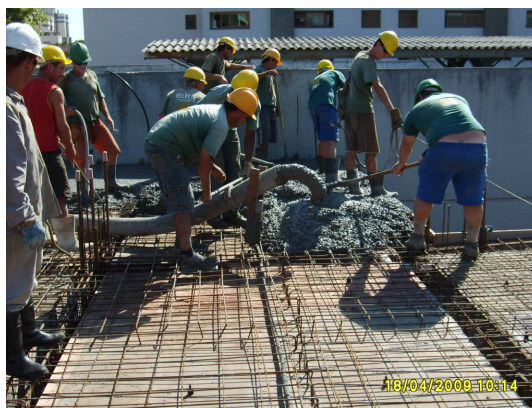
Figura 5: concreto bombeado
