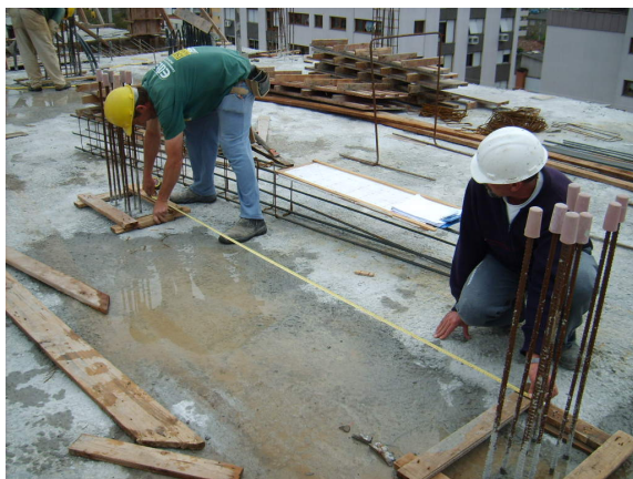
Figura 12: locação dos pilares no pavimento
