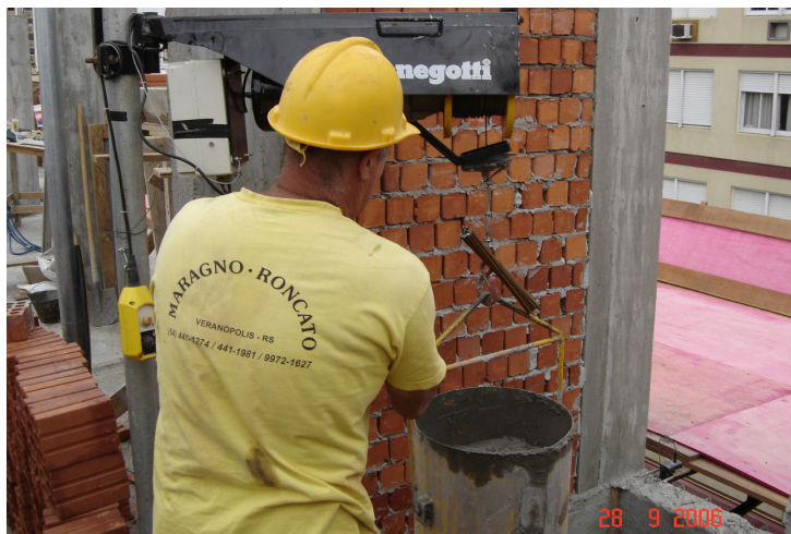
Figura 16: recebimento de argamassa no pavimento
