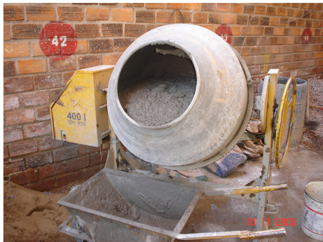
Figura 24: argamassa produzida em obra
