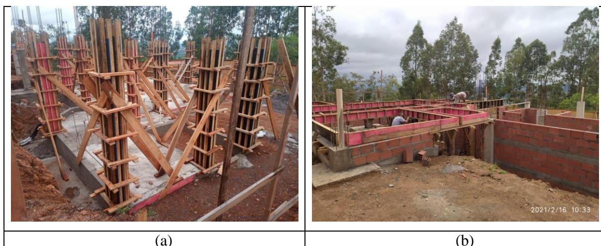
Figura 18: Estudo de Caso (a) Formas dos pilares - 04/02 e (b) Alvenaria e Formas de vigas - 16/02
