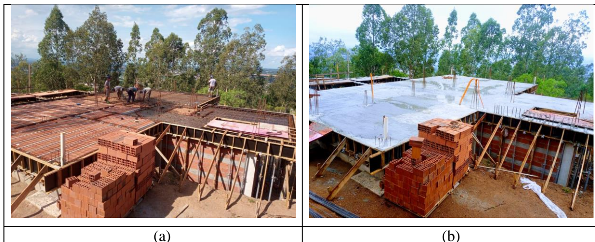
Figura 28: Estudo de Caso (a) Ferragem Laje - 02/03 e (b) Concretagem - 05/03
