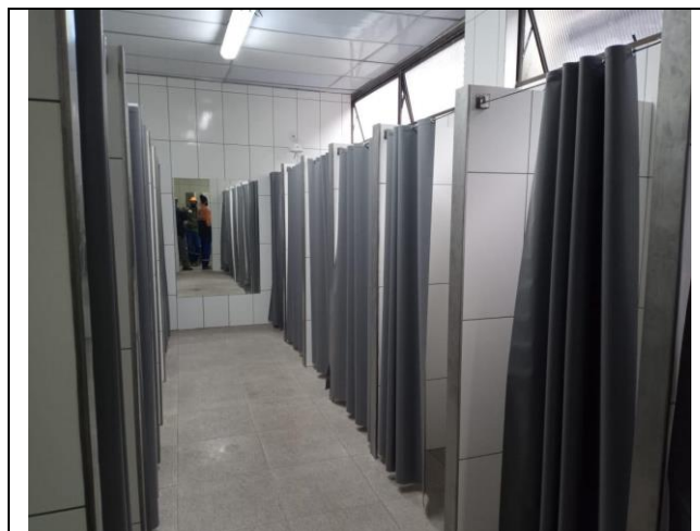
Figura 12: Obra Pirelli - Vestiário Finalizado
