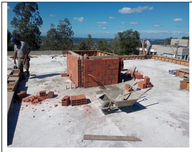
Figura 41: Estudo de Caso - Alvenaria para Laje de Caixa d'Água - Foto 23/04
