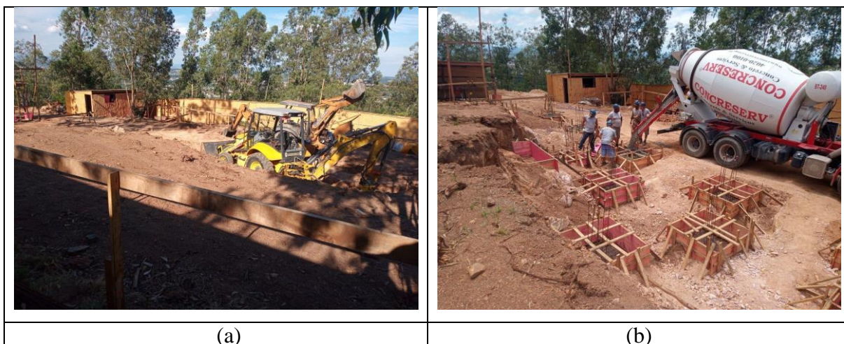
Figura 16: Estudo de Caso (a) Terraplanagem - 07/01 e (b) Concretagem de Sapatas - 15/01
