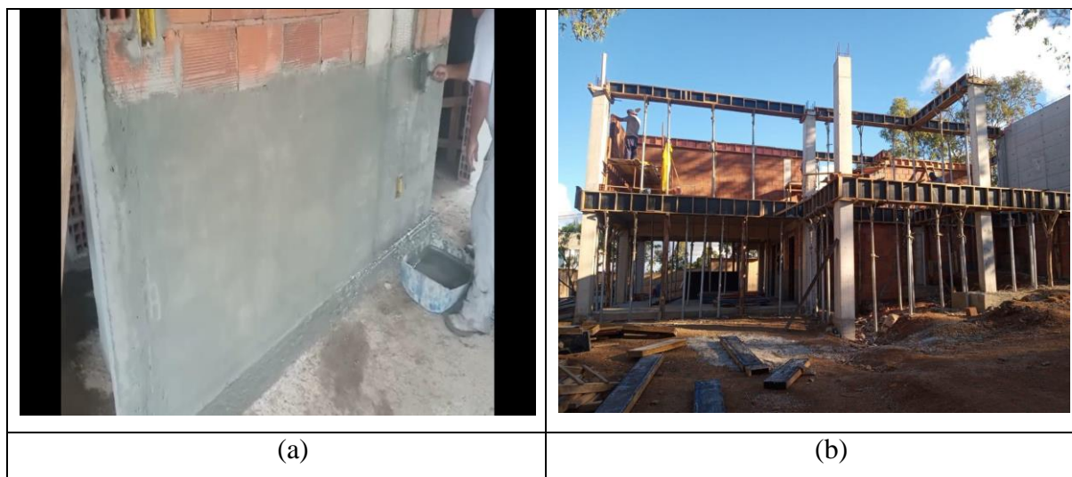
Figura 34: Estudo de Caso (a) Impermeabilização Paredes - 26/03 e (b) Alvenaria e Formas Vigas - 24/03
