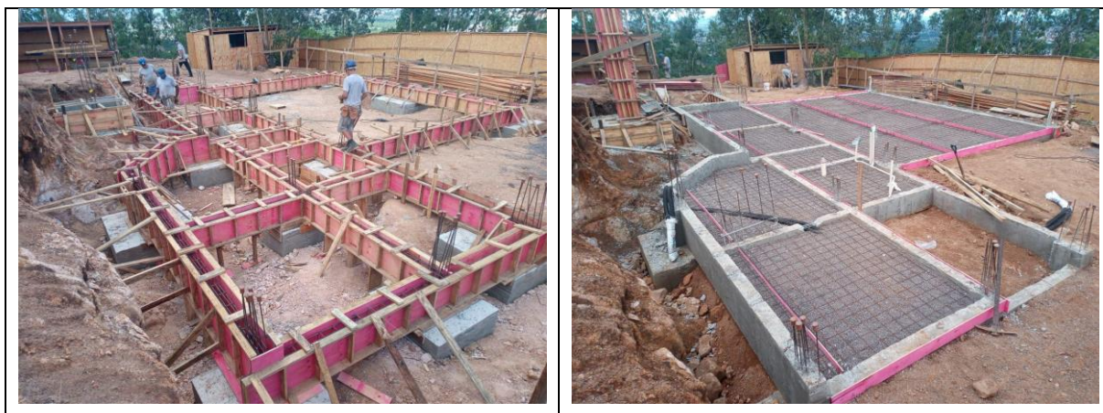
Figura 17: Estudo de Caso (a) Formas dos Baldrames - 22/01 e (b) Preparação para Contrapiso - 29/01
