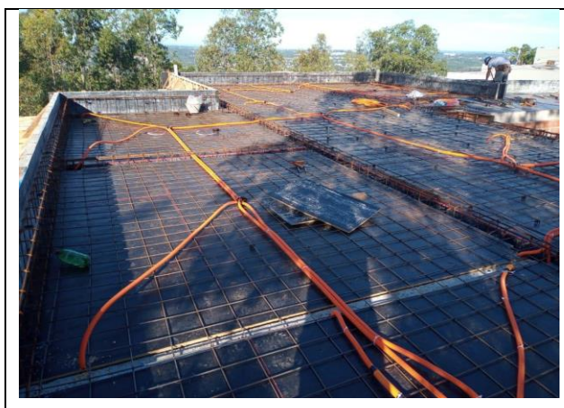
Figura 37: Estudo de Caso - Instalações da Laje - 08/04
