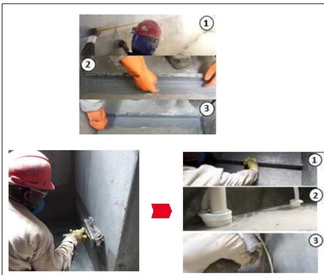
Figura 24 – Impermeabilização piso e parede
