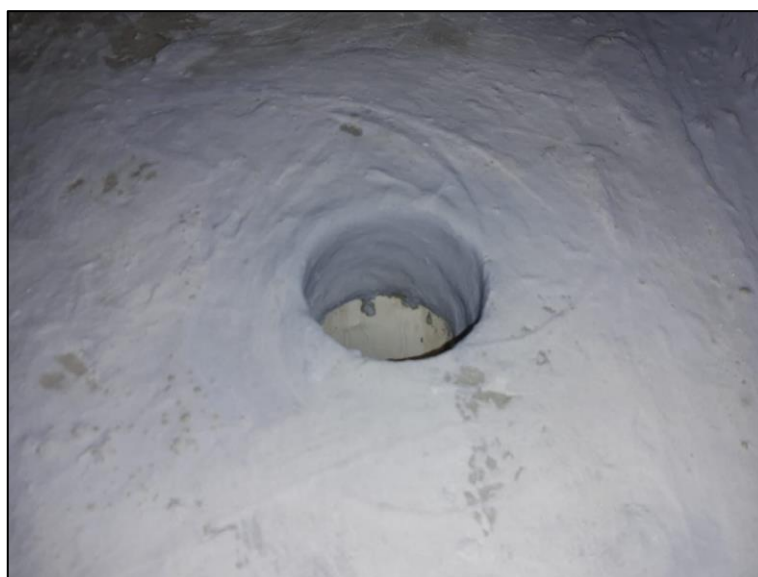
Figura 49 – Impermeabilização do ralo sem bloco de espuma
