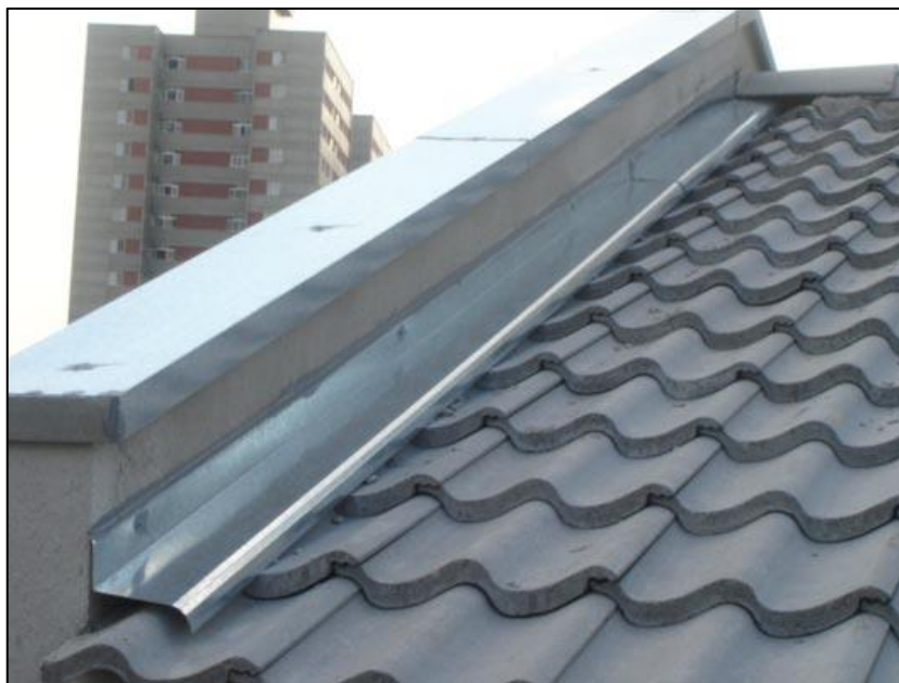
Figura 55 – Rufo tipo pingadeira em platibanda
