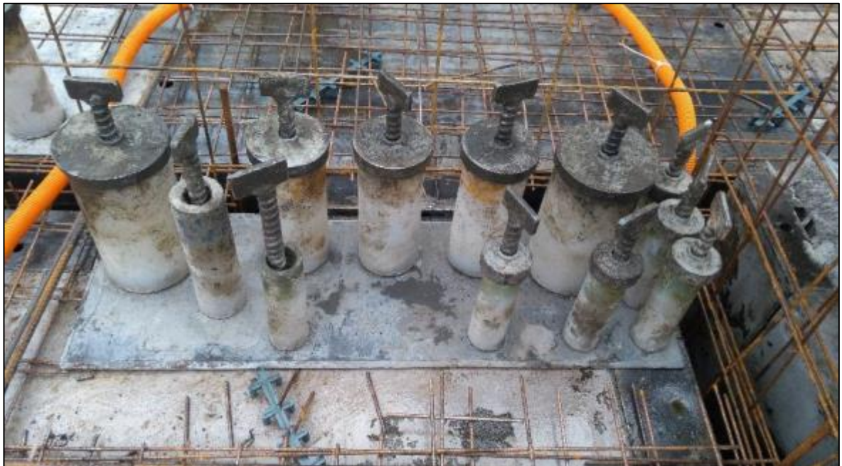
Figura 44 – Gabarito do shaft posicionado na fôrma
