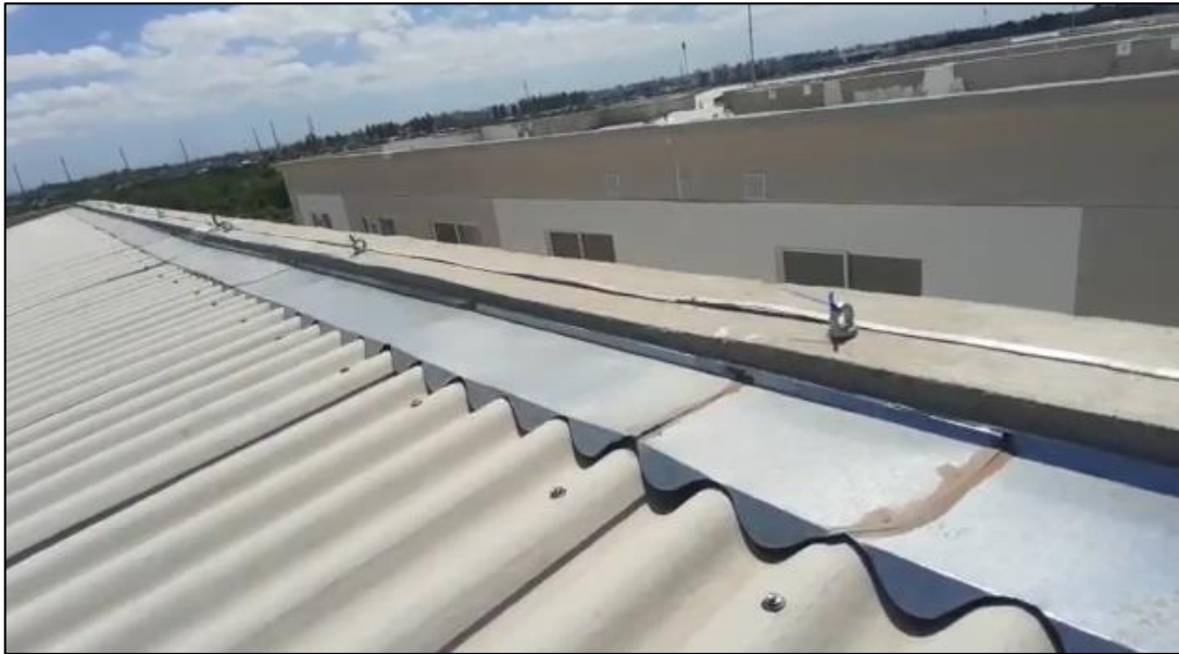
Figura 39 – Extensão do rufo no telhado
