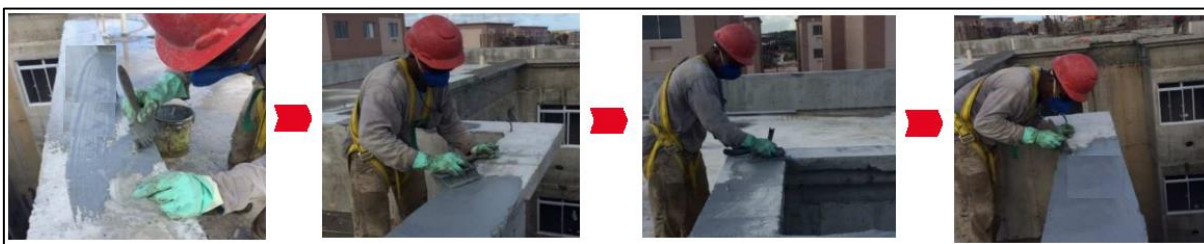
Figura 31 – Impermeabilização no topo da platibanda
