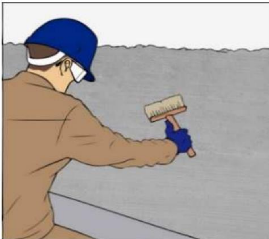
Figura 30 – Limpeza da superfície
