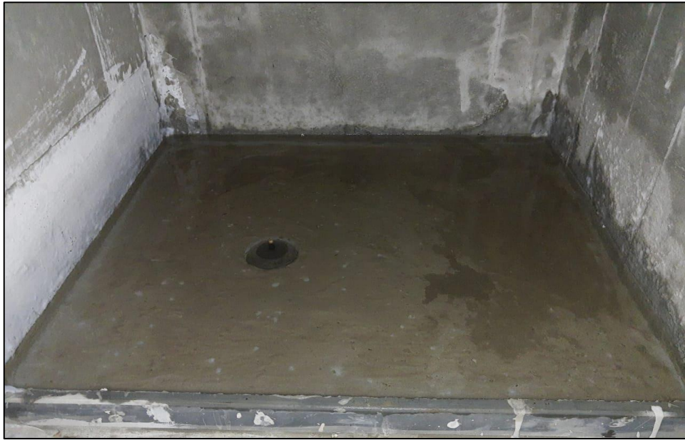
Figura 52 – Box em teste de estanqueidade com o balão no ralo
