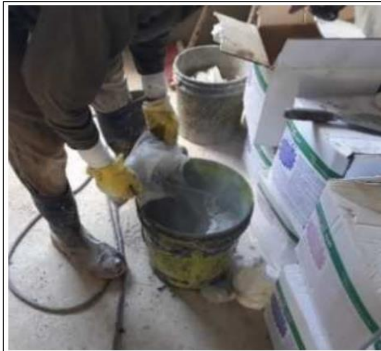
Figura 28 – Preparação do impermeabilizante
