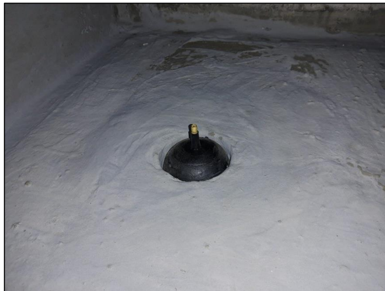
Figura 51 – Balão posicionado no ralo e pronto para iniciar o teste
