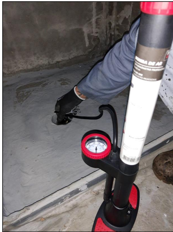
Figura 50 – Colocação do balão no ralo
