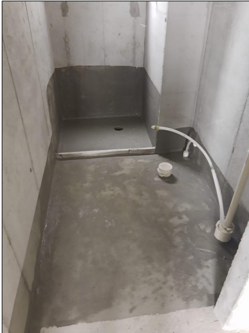
Figura 26 – Impermeabilização executada no banheiro
