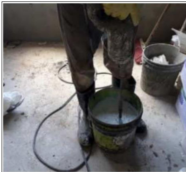
Figura 29 – Mistura do impermeabilizante
