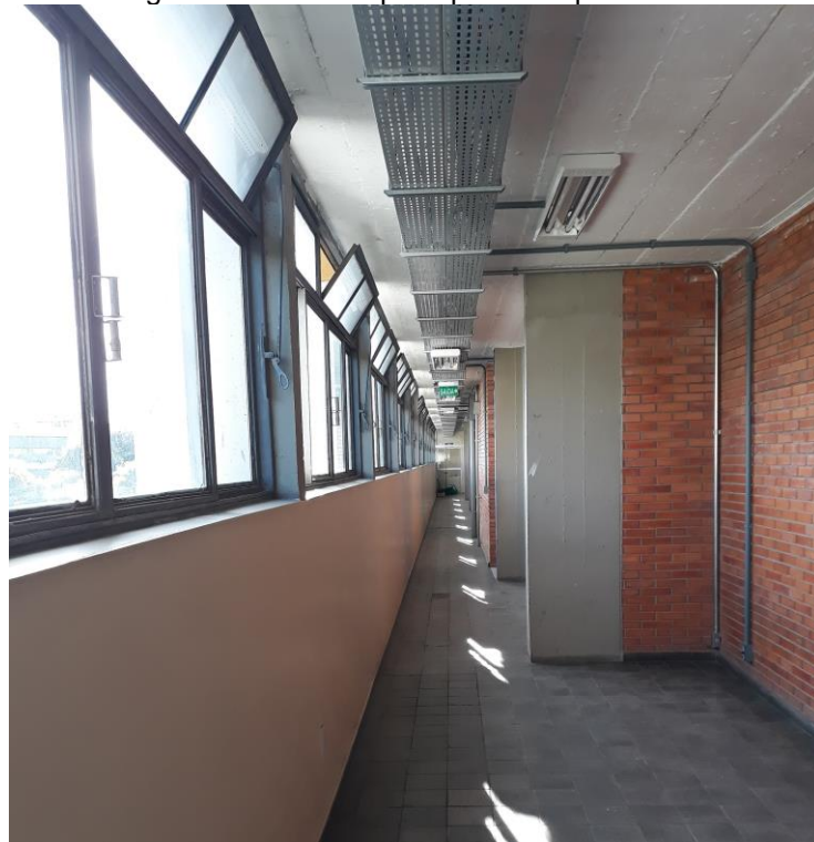
Figura 5 - Corredor principal do 3º pavimento
