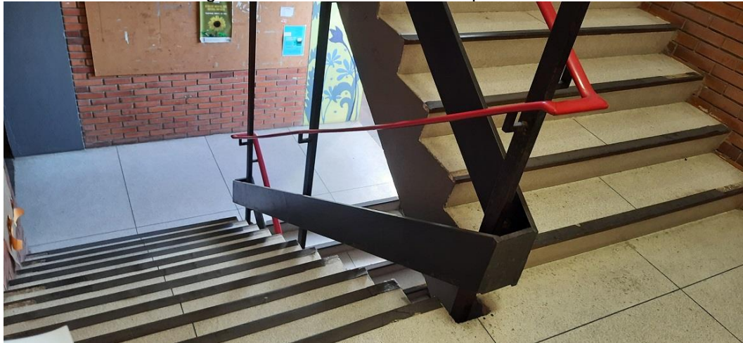
Figura 9 - Escada existente no 3º pavimento
