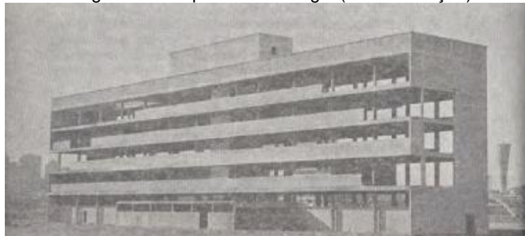
Figura 2 - Hospital de Tisiologia (em construção)
