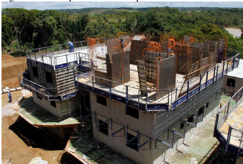
Figura 6 – Execução do sistema de paredes de concreto moldadas in loco
