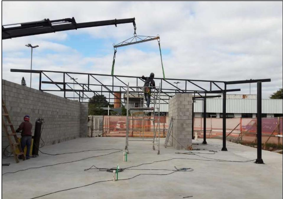
**Figura 24: Montagem da cobertura metálica – Prédio de Apoio**
