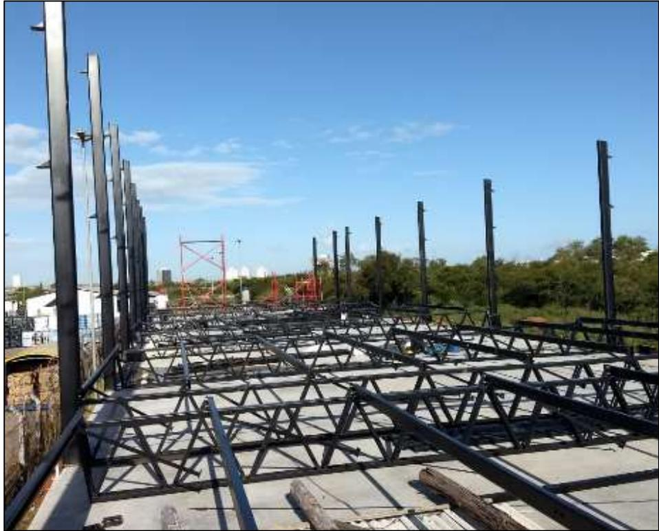
**Figura 17: Montagem da estrutura metálica – Prédio Administrativo**
