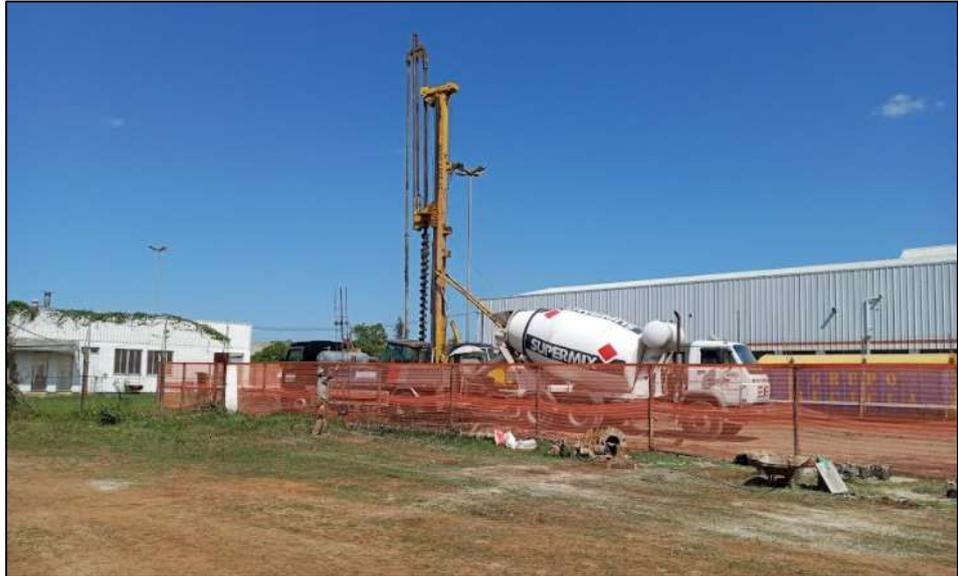
**Figura 11: Fundações profundas do tipo estaca hélice contínua – Prédio Administrativo**
