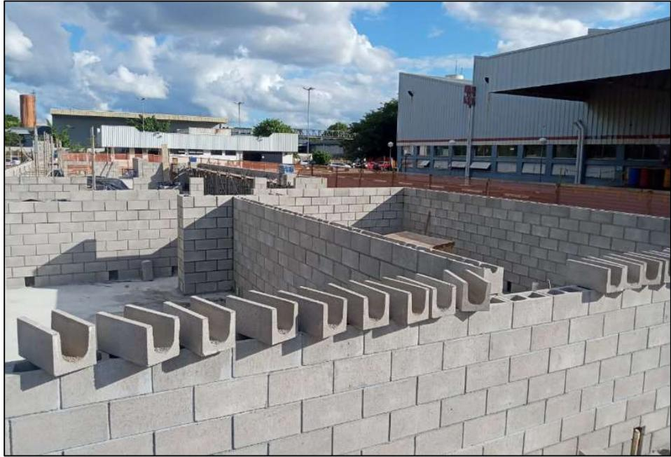
**Figura 23: Execução de alvenaria estrutural – Prédio de Apoio**
