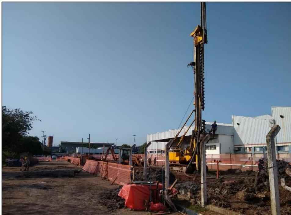
**Figura 20: Fundações profundas do tipo estaca hélice contínua – Prédio de Apoio**
