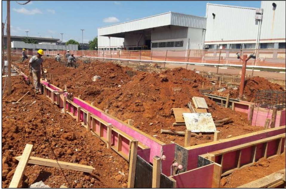
**Figura 21: Blocos e vigas de fundação – Prédio de Apoio**
