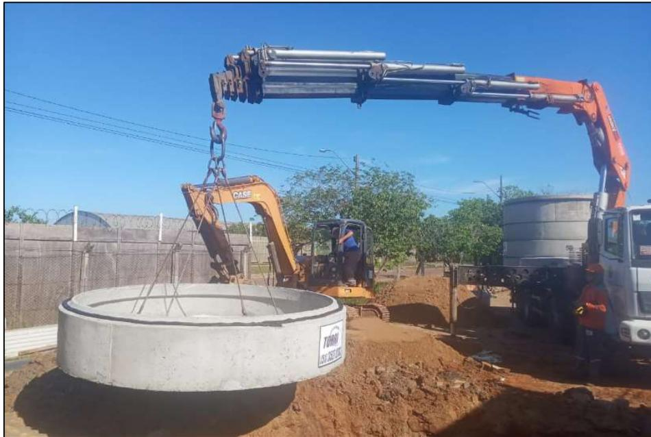
**Figura 29: Instalação de fossa e filtro**
