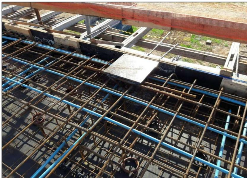
**Figura 8: Armação da laje do Prédio Administrativo junto aos pilares**
