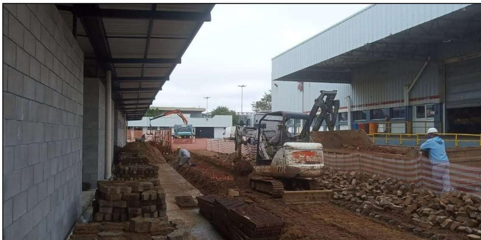
**Figura 30: Escavação para readequação das redes enterradas existentes**
