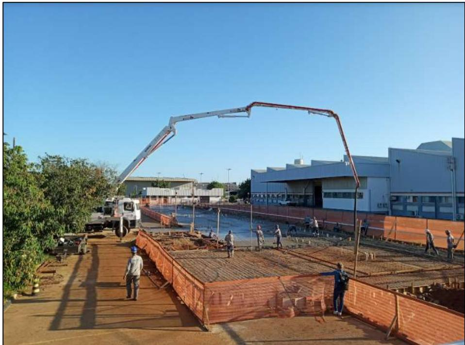
**Figura 22: Concretagem da laje térrea – Prédio de Apoio**
