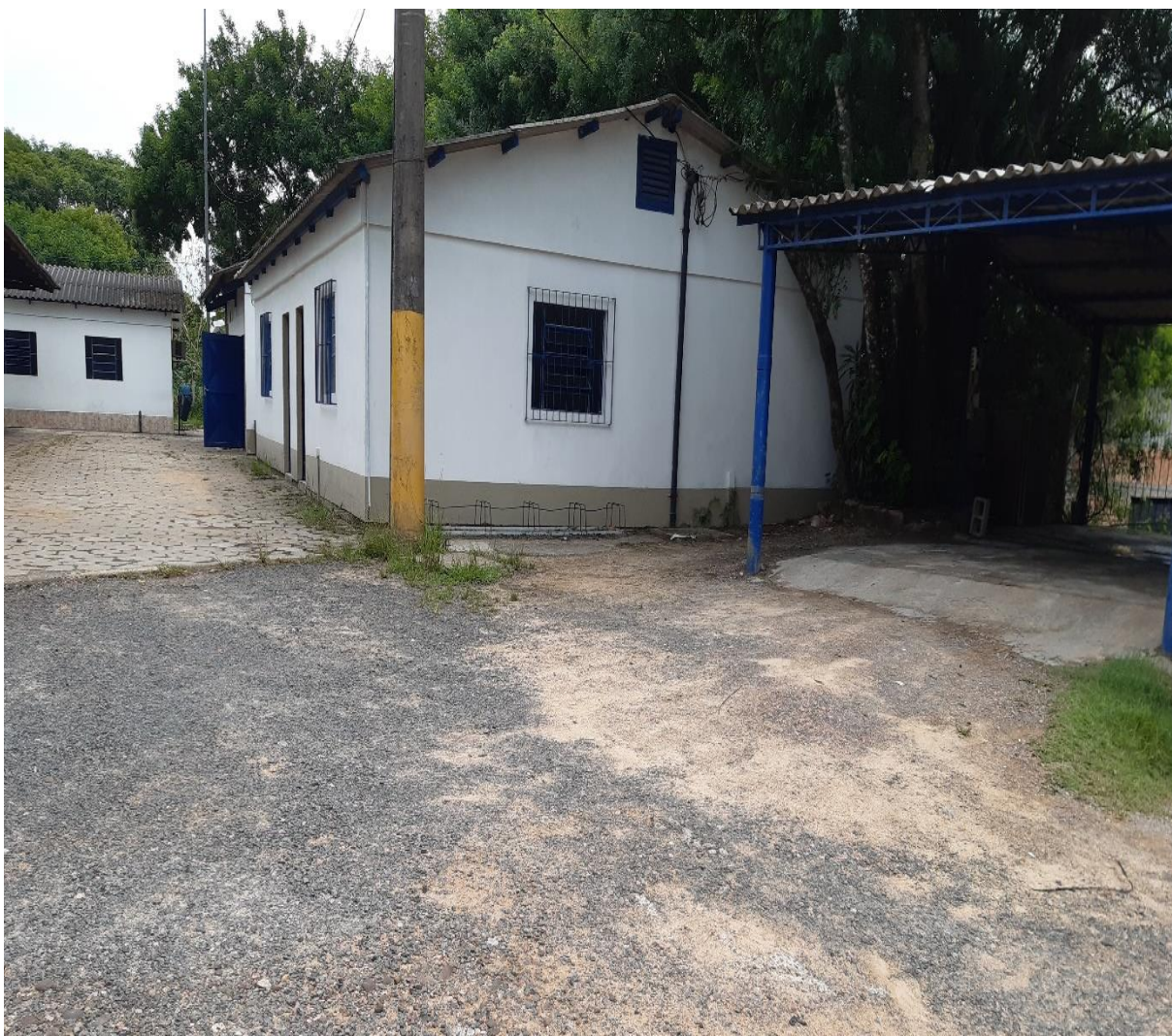
Figura 79 – Acesso à Unidade de Serviços
