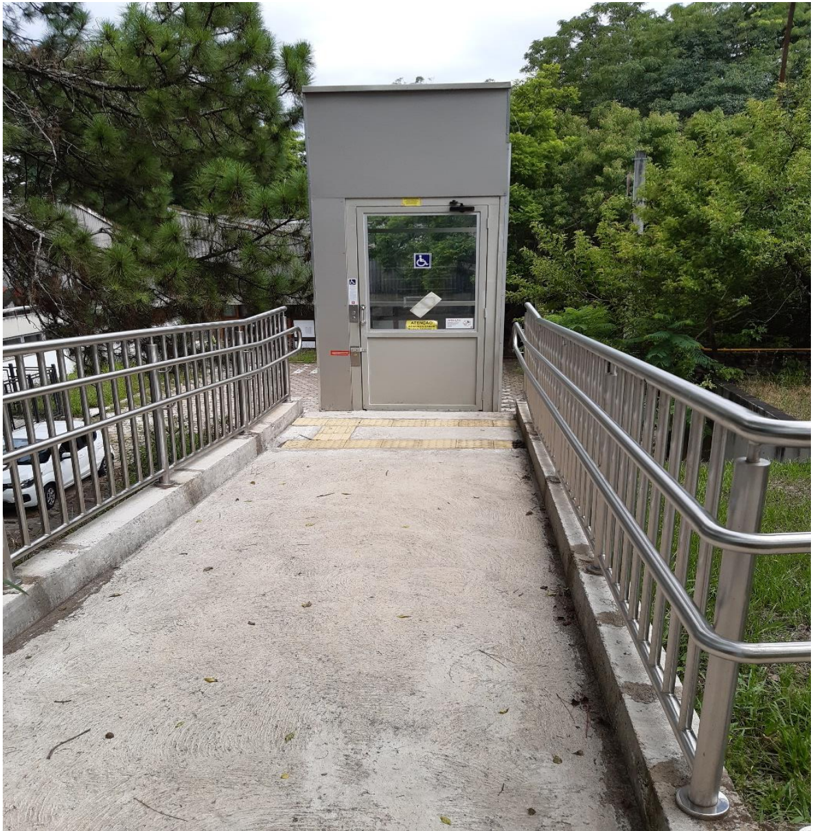
Figura 63 – Plataforma elevatória do RU 3
