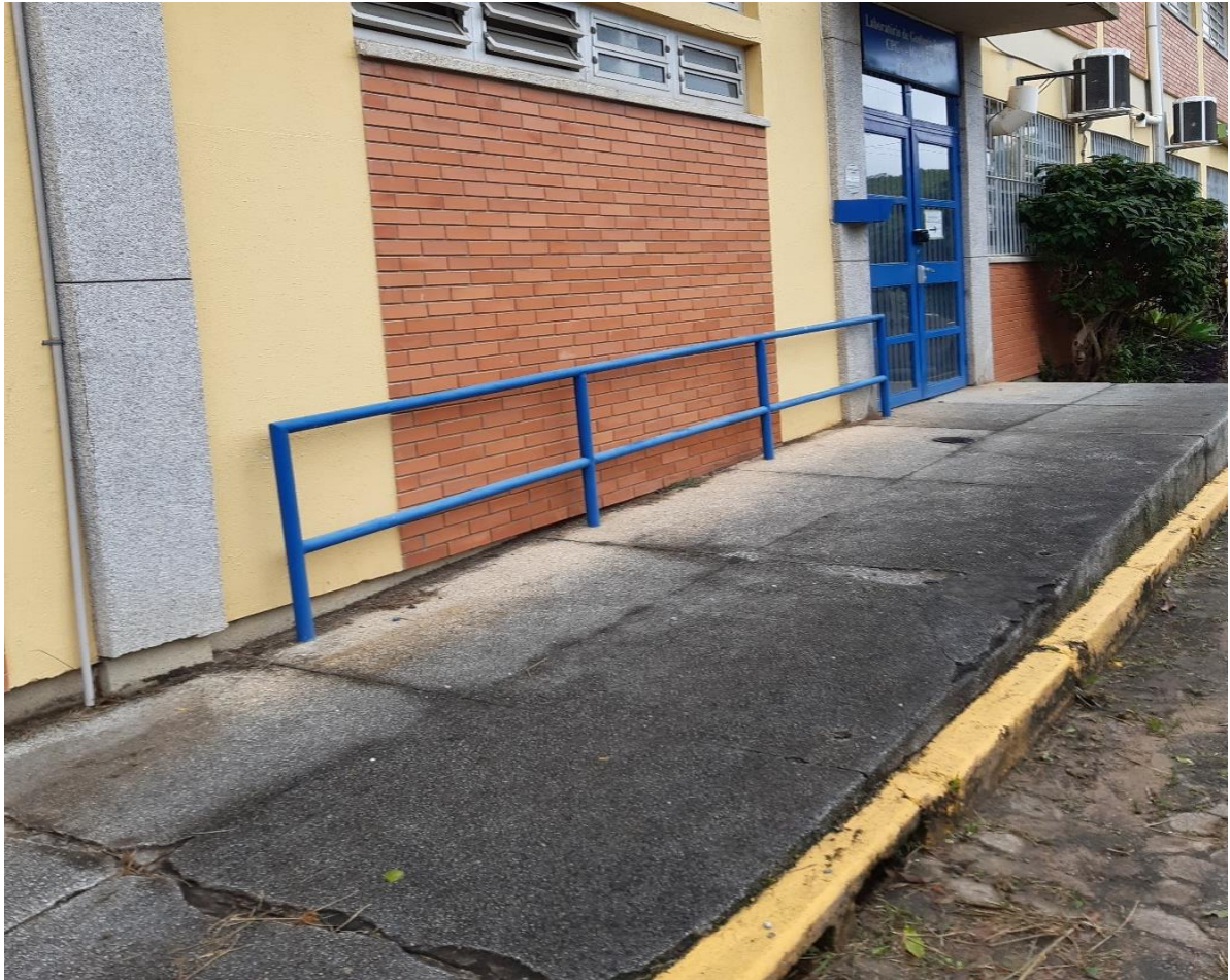
Figura 65 – Acesso ao prédio 43129
