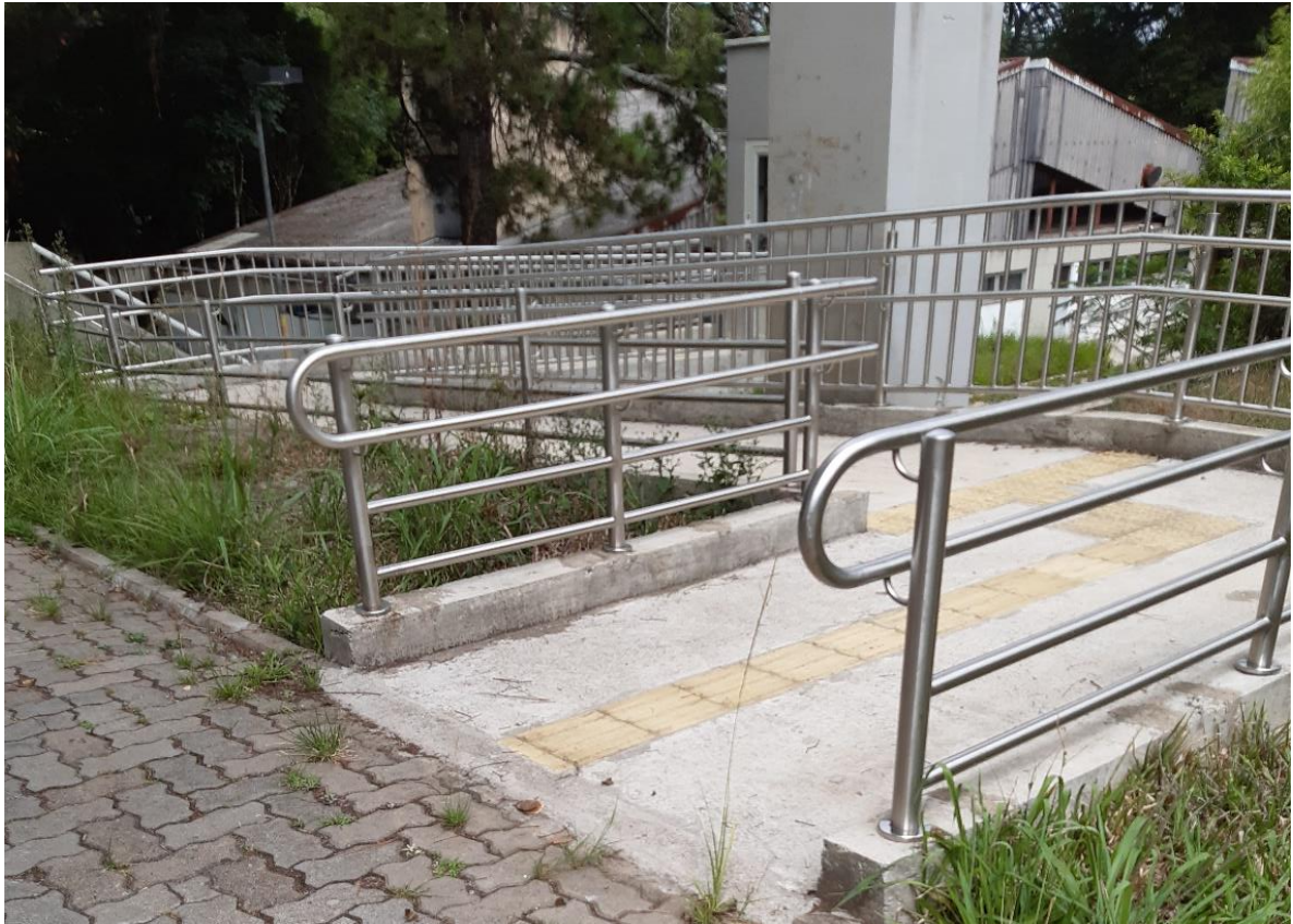
Figura 62 – Rampa de acesso à plataforma elevatória do RU 3
