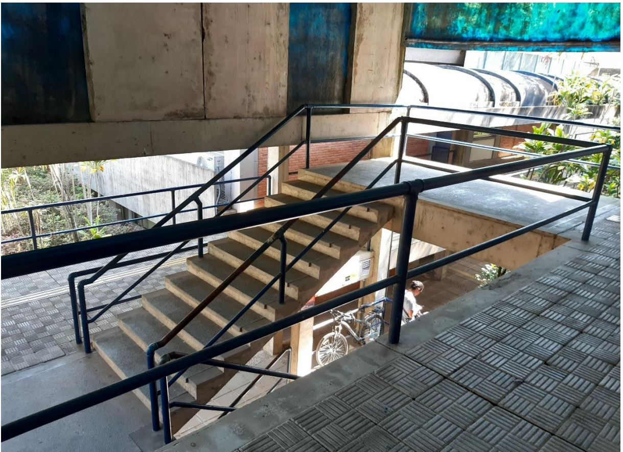
Figura 46 - Escadas de acesso
