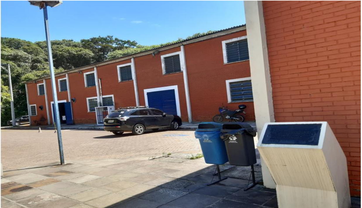
Figura 70 – Acesso ao prédio 43807
