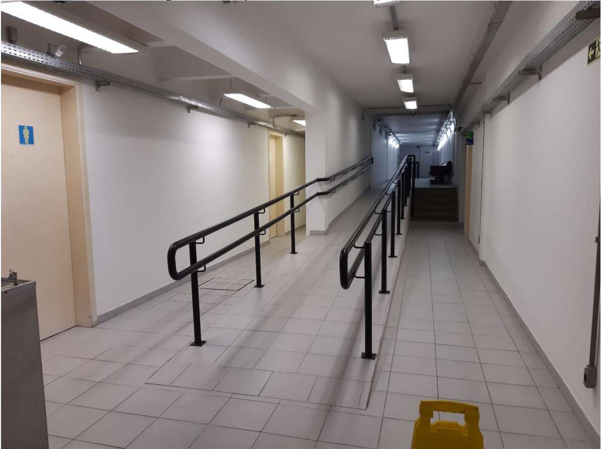
Figura 58 – Rampa interna no subsolo do prédio 43212
