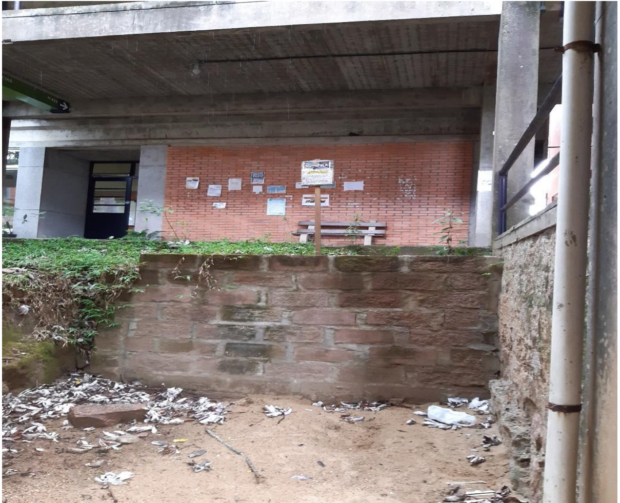
Figura 48 - Local de futura instalação de plataforma elevatória entre 43421 e 43422
