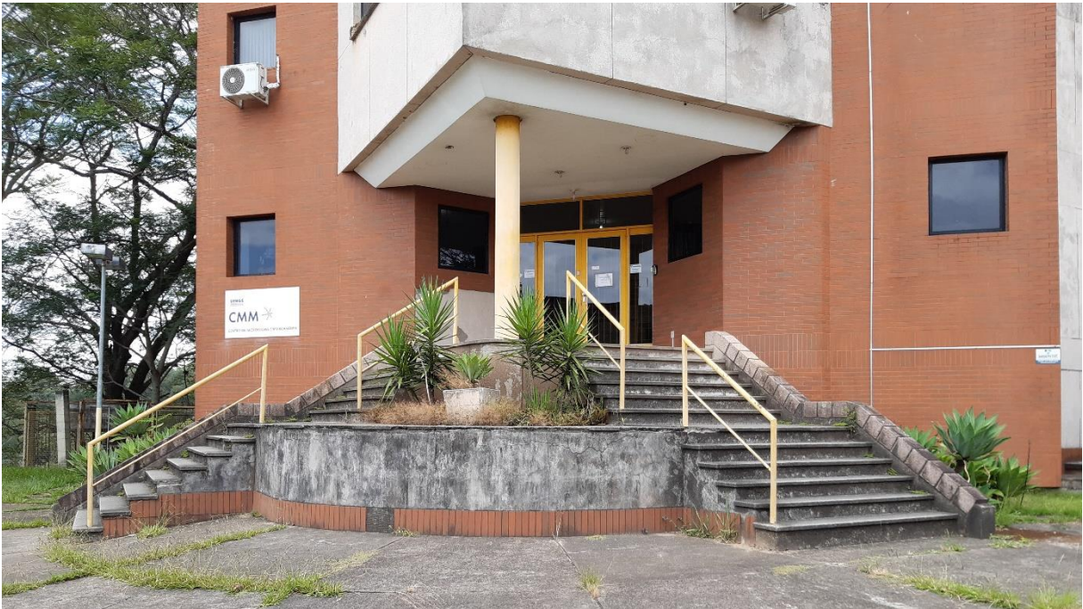
Figura 67 – Acesso ao prédio 43177
