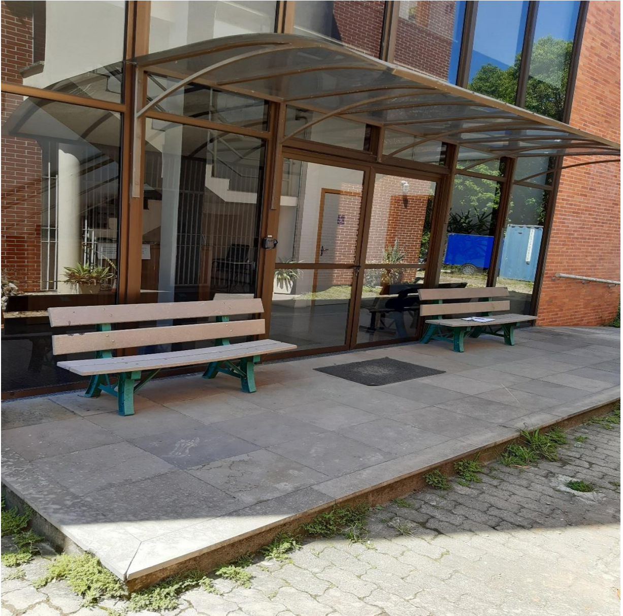
Figura 71 – Acesso ao prédio 43817
