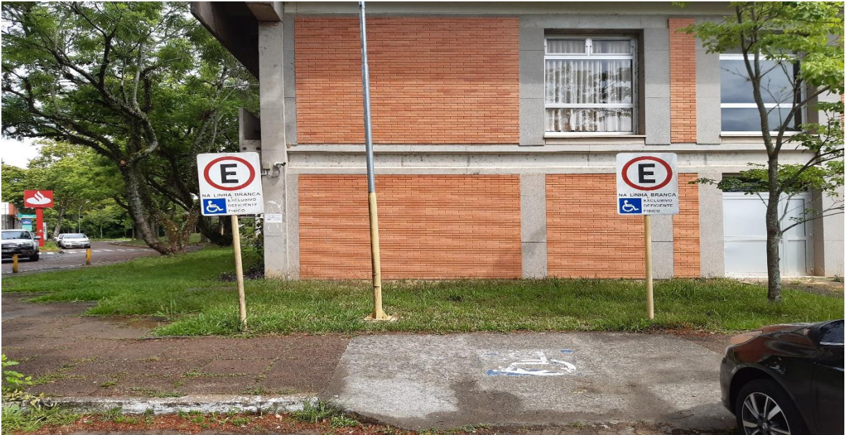
Figura 54 - Estacionamento do prédio 43321
