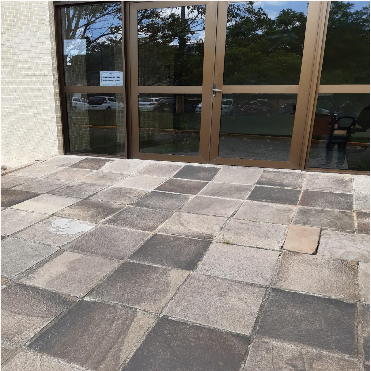
Figura 66 – Acesso ao prédio 43130
