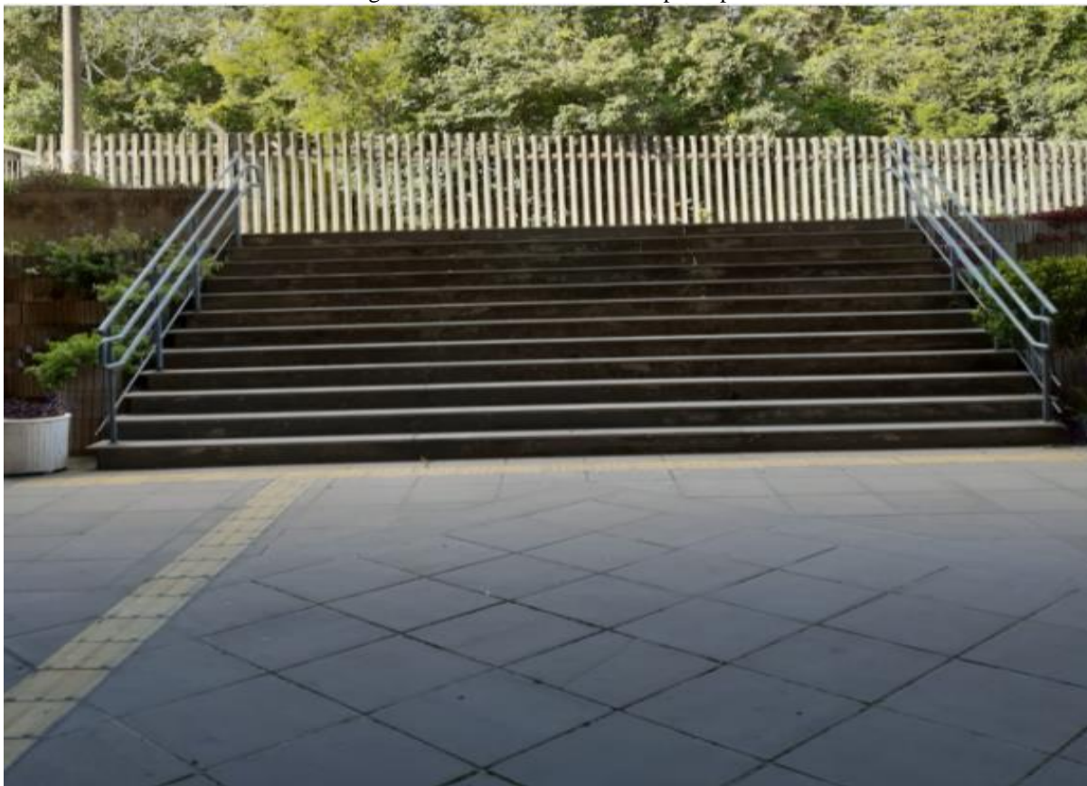
Figura 82 – Escadaria de acesso principal
