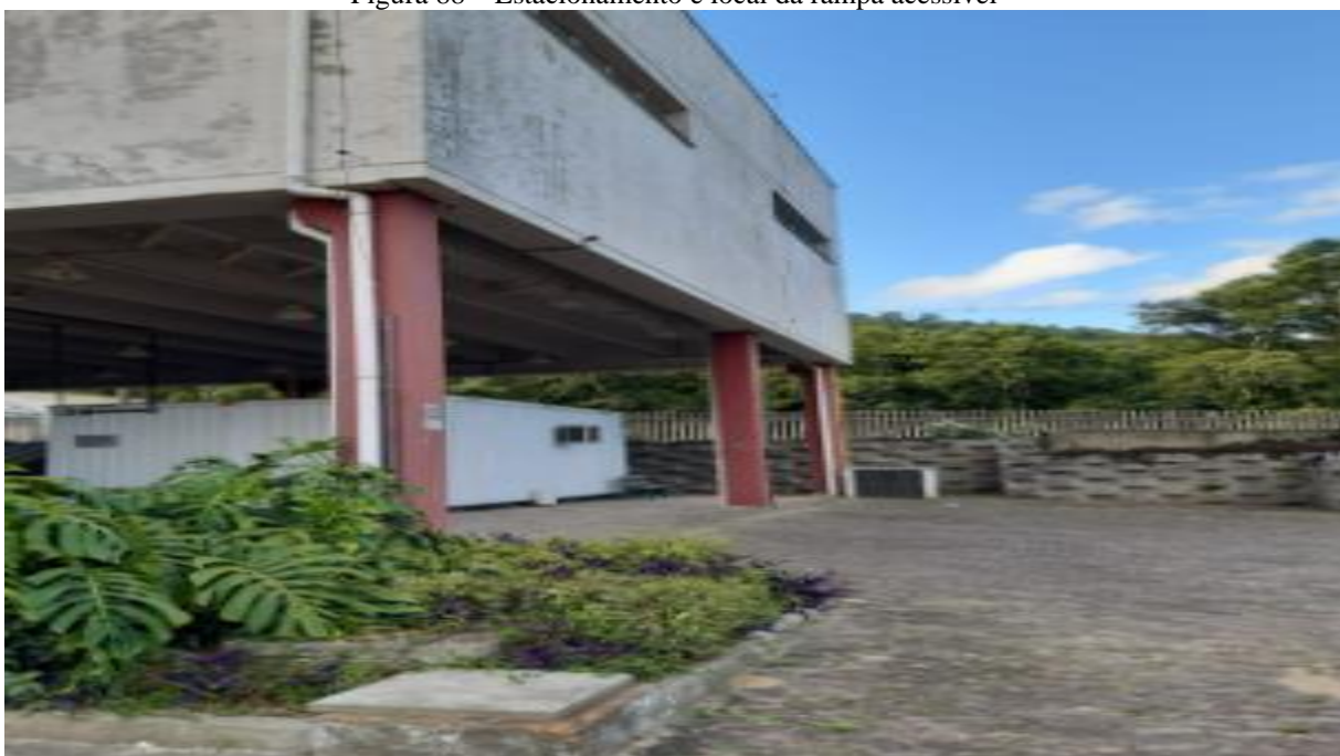
Figura 88 – Estacionamento e local da rampa acessível
