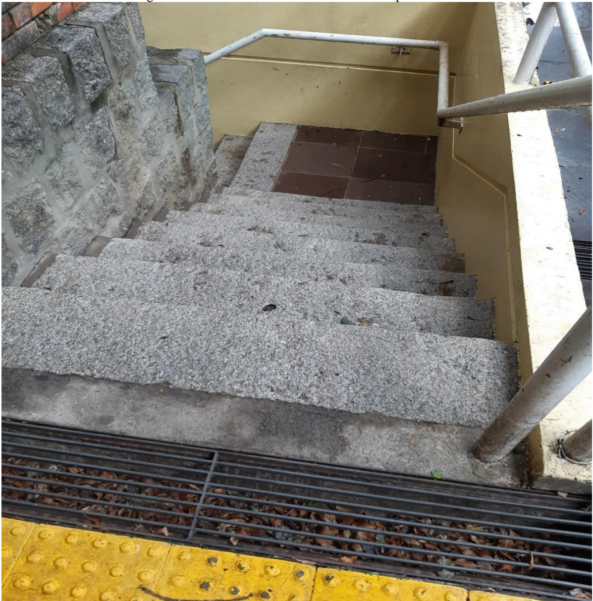
Figura 57 – Acesso ao restaurante no subsolo do prédio 43211
