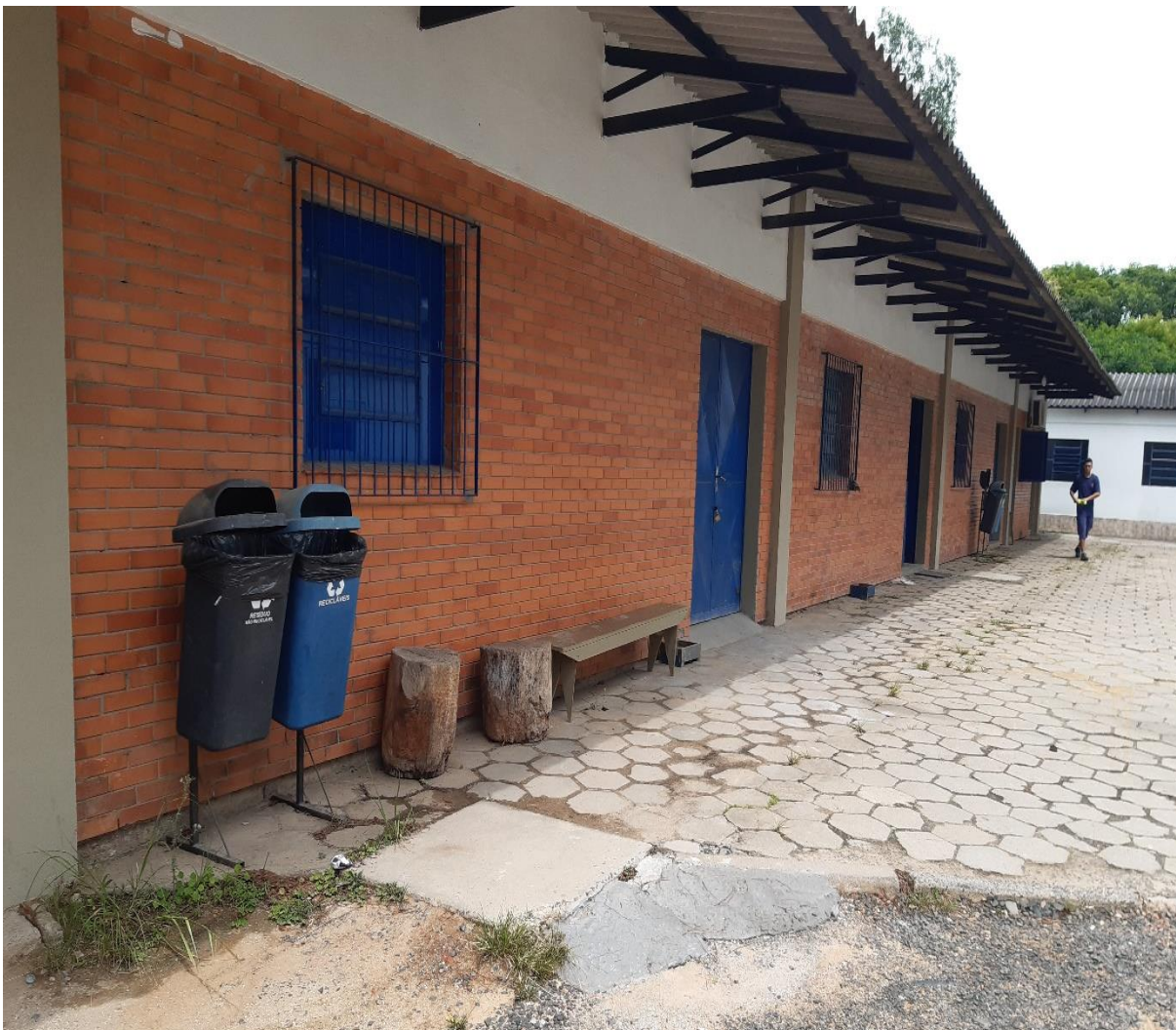
Figura 78 – Acesso à Unidade de Serviços
