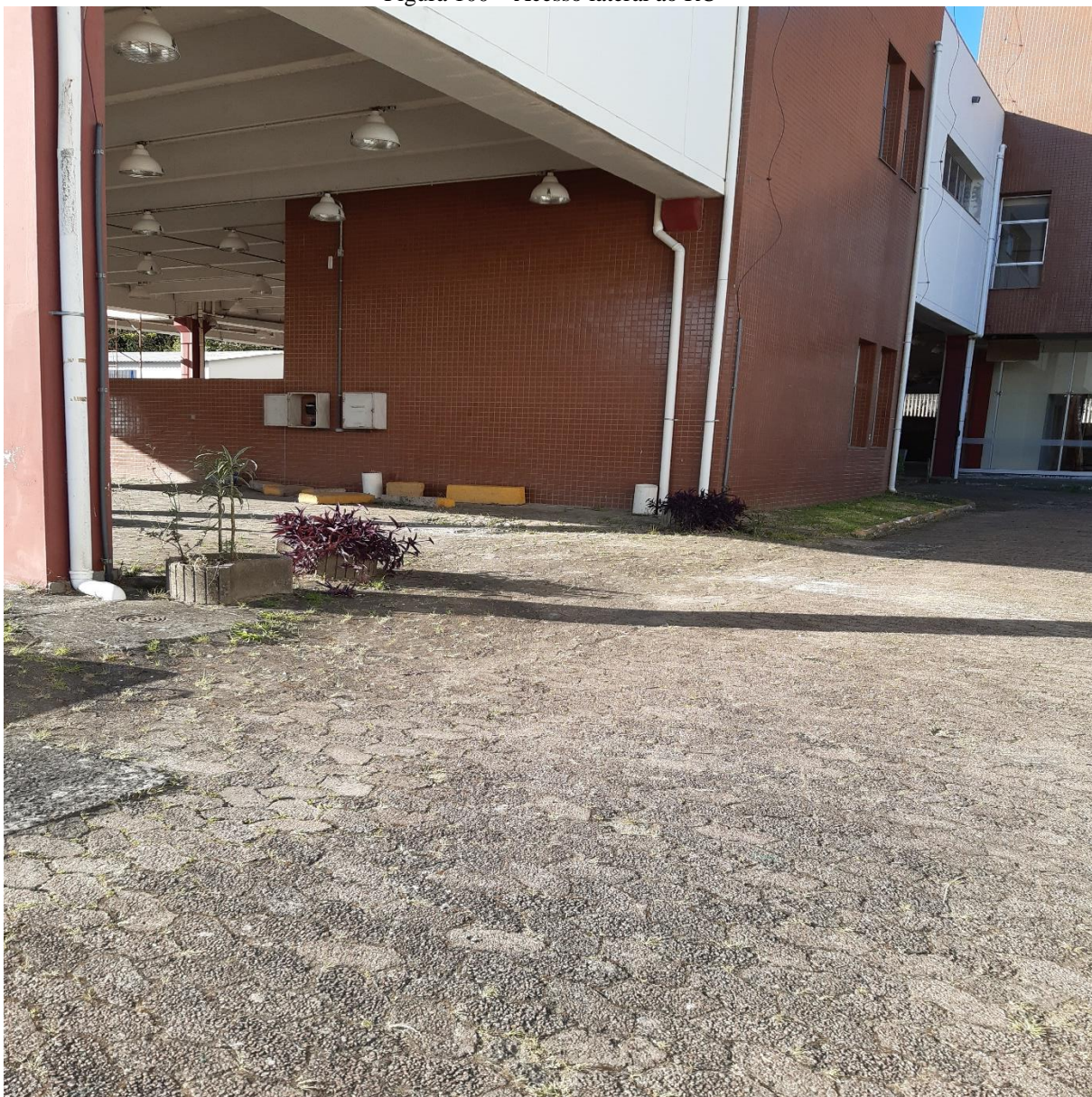
Figura 100 – Acesso lateral ao RU
