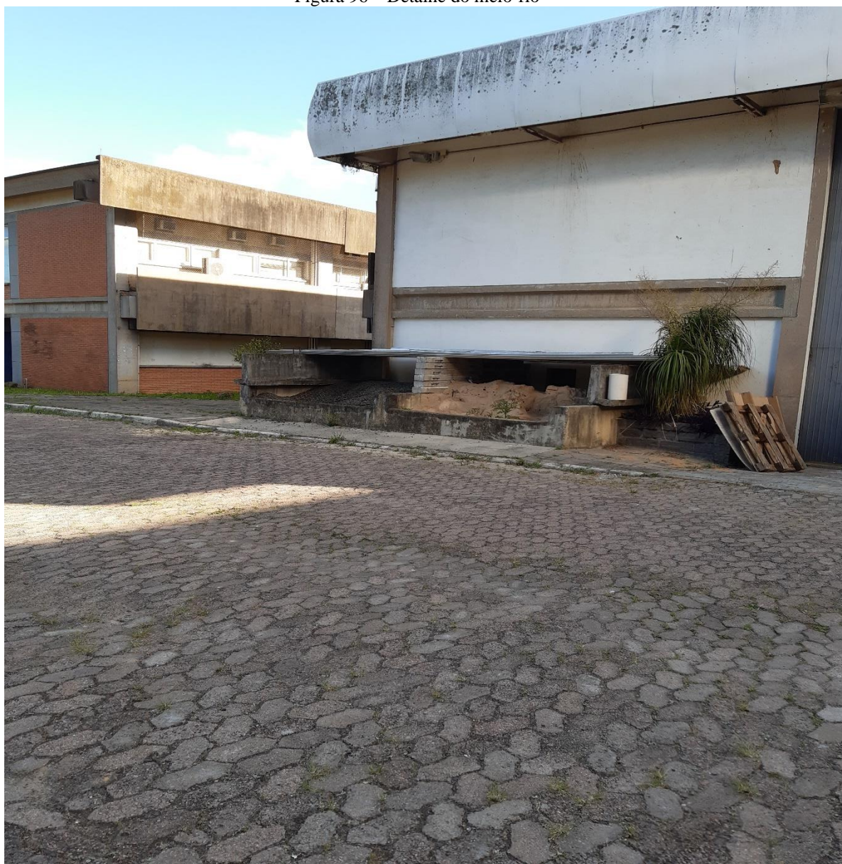
Figura 96 – Detalhe do meio-fio
