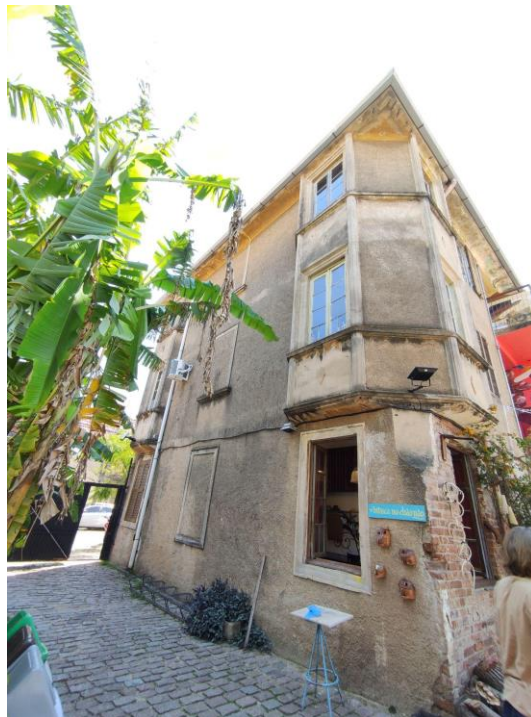
Figura 17: Fachada sudoeste do edifício São Carlos
