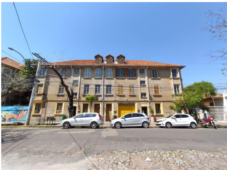
Figura 22: Fachada noroeste do edifício São Carlos
