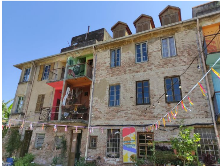
Figura 16: Fachada sudeste do Edifício São Carlos
