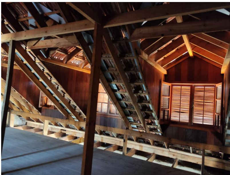
Figura 31: Assoalho e estrutura do telhado no sótão
