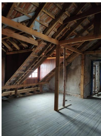
Figura 30: Assoalho e estrutura do telhado no sótão
