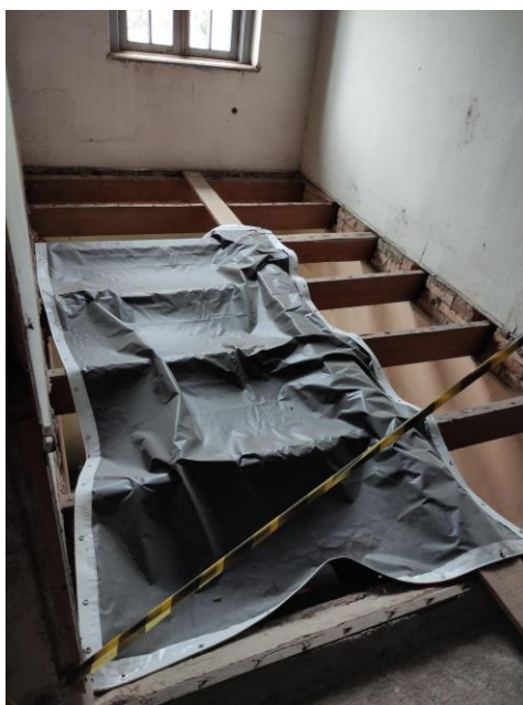
Figura 26: Exemplos de locais que necessitam reconstrução de entrepiso
