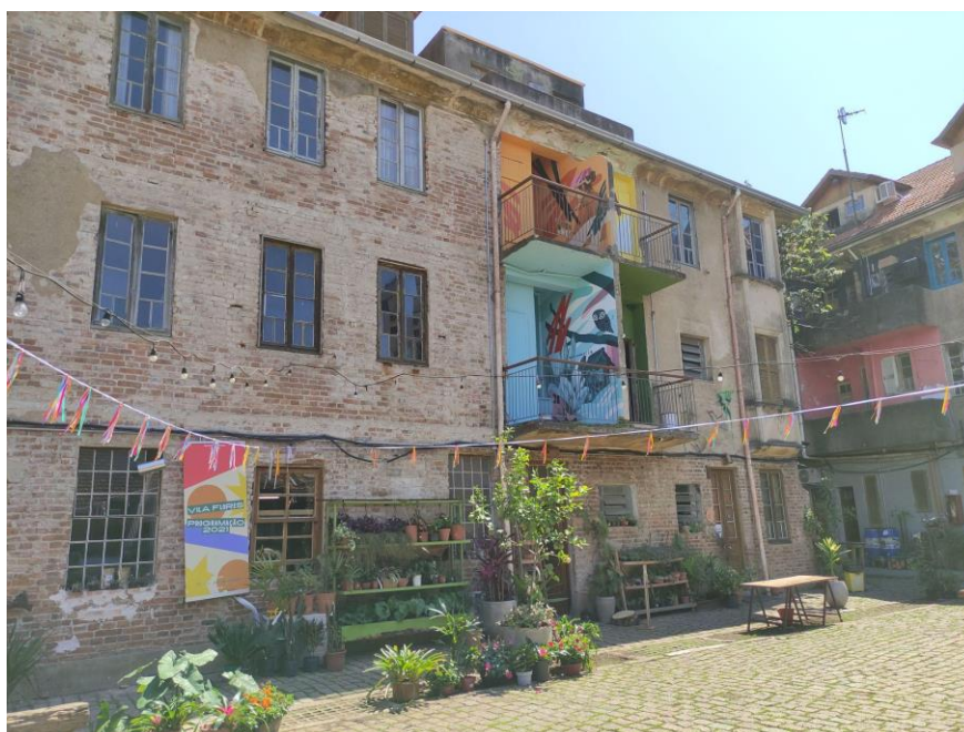
Figura 20: Fachada sudeste do Edifício São Carlos
