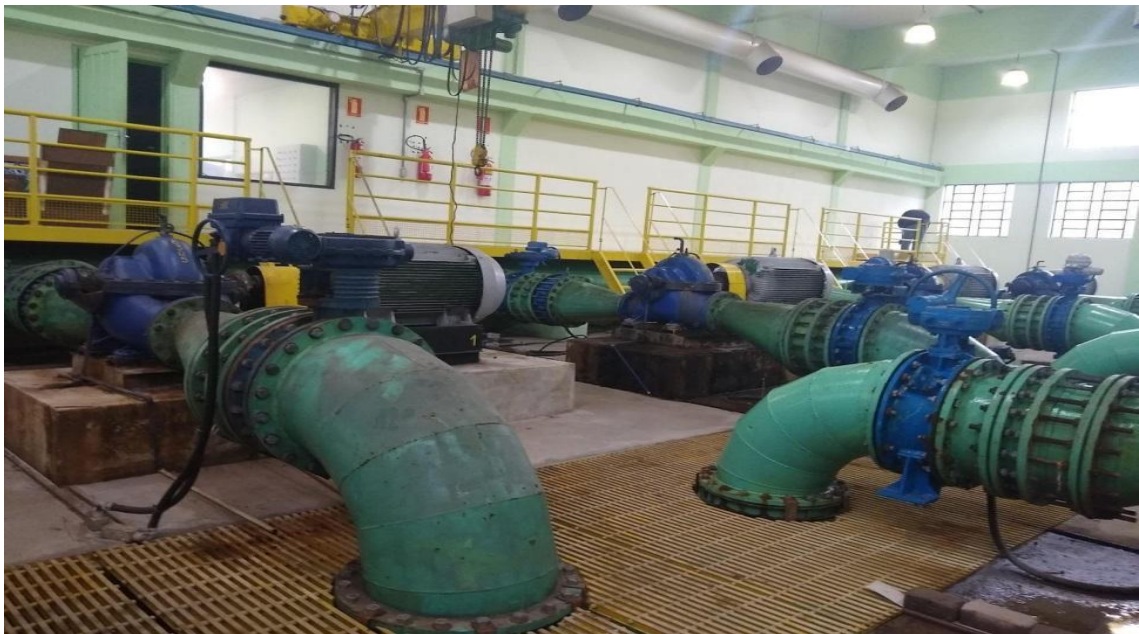
Figura 10: Arranjo geral dos grupos motor/bomba da EBAT Cascatinha. Fonte: Elaborado pela autora.
