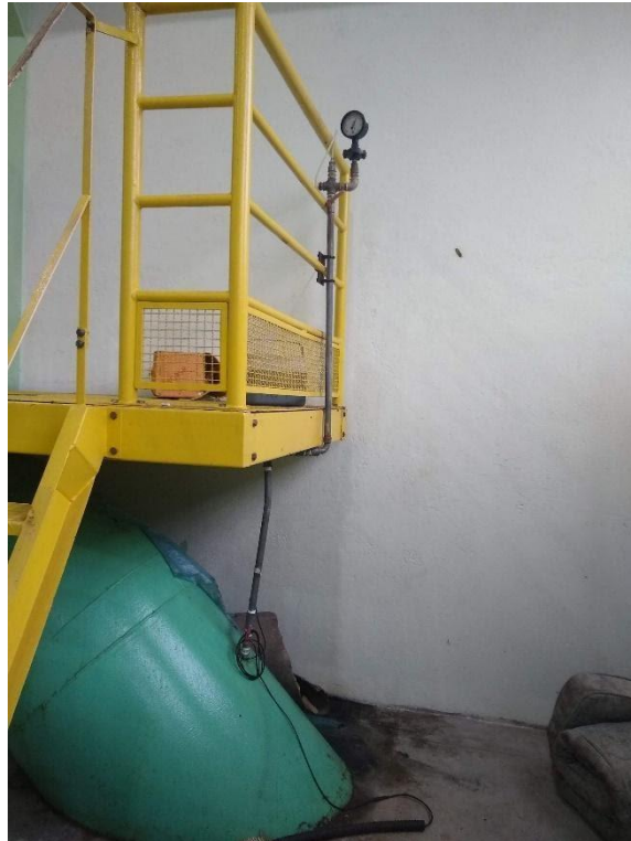
Figura 19: Datalogger instalado no recalque da EBAT Cascatinha/RES Catumbi. Fonte: Elaborado pela autora.
