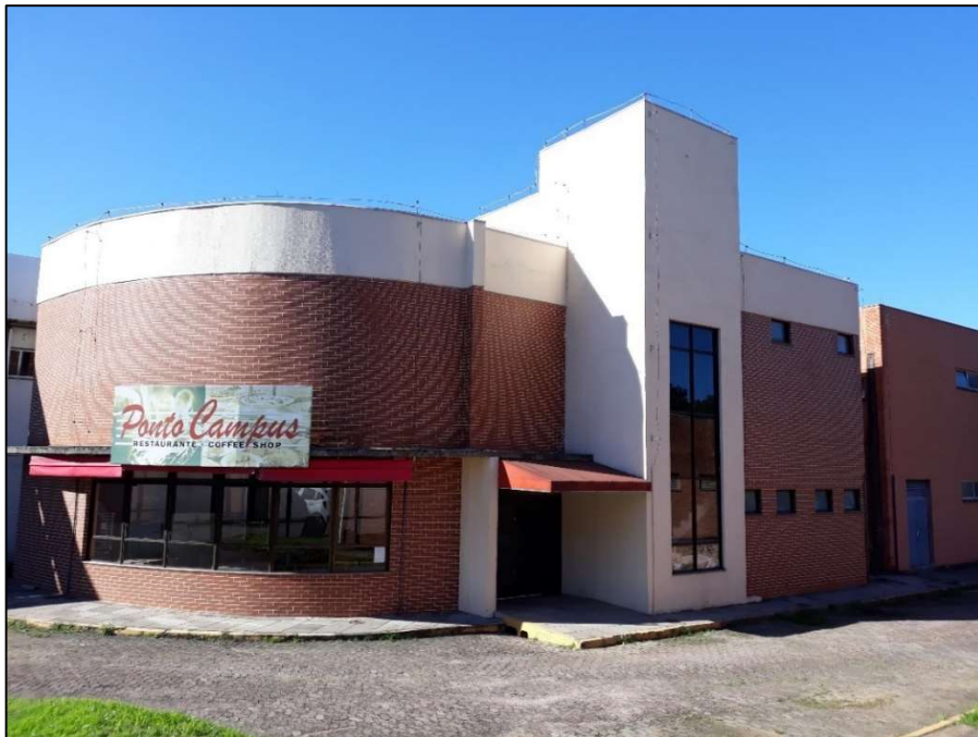
Figura 3: Prédio 43466 - Restaurante Ponto Campus.
