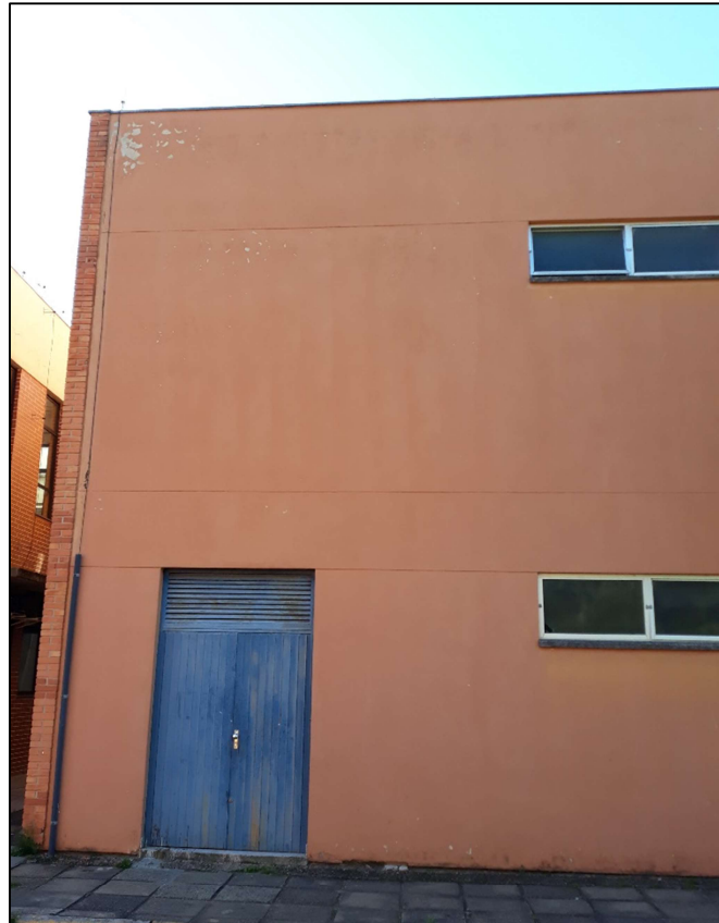
Figura 2: Prédio 43465 – Sanitários, área de confraternização e diretório acadêmico.
