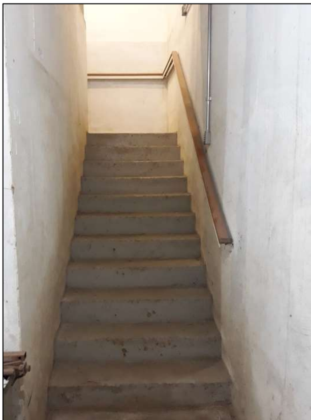
Figura 19: Acabamento das paredes da escada do subsolo ao térreo.
