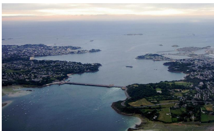
Figura 2 – Vista aérea da Usina de La Rance
