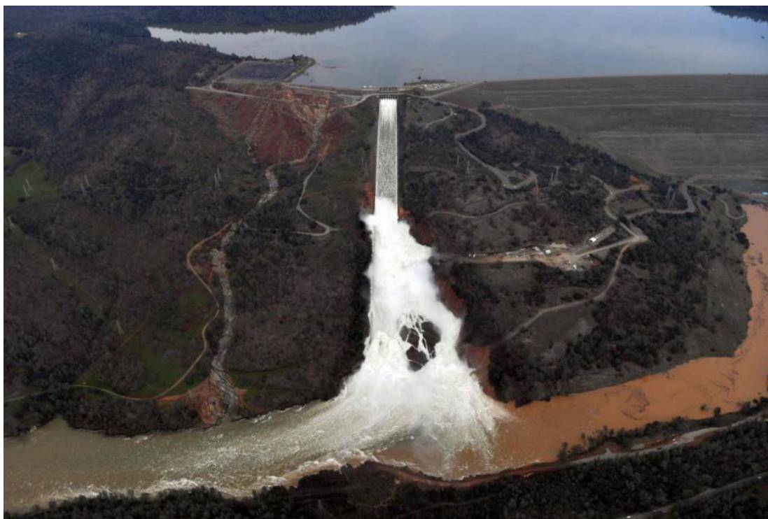
Figura 18 – Danos no vertedouro da barragem de Oroville. Adaptado de Elpais, 2017.
