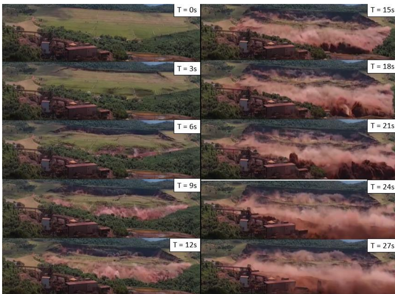
Figura 16 – Evolução da ruptura da barragem de Brumadinho. Adaptado de Record News, 2019.
