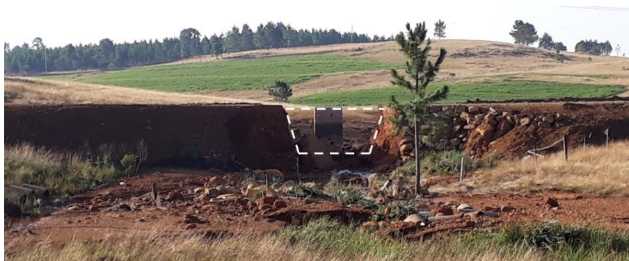
Figura 24 – Foto de brecha trapezoidal (barragem de irrigação – São Francisco de Paula / BR). Fonte: Acervo Pessoal
