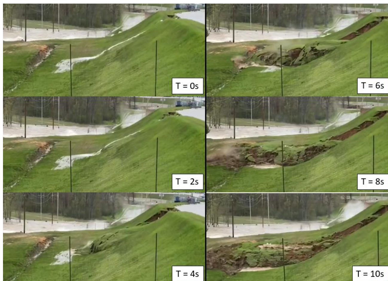
Figura 15 – Evolução da ruptura da barragem de Edenville, em 2020. Adaptado de MLIVE, 2020.
