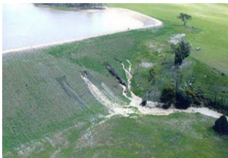
Figura 14 – Processo de falha devido a Piping (Fonte: BELCHER & CAMP & KRZHIZHANOVSKAYA, 2015)
