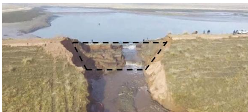
Figura 23 – Foto de brecha trapezoidal (Barragem Sardoba - Uzbequistão). Fonte: Hydropower & Dams, 2022
