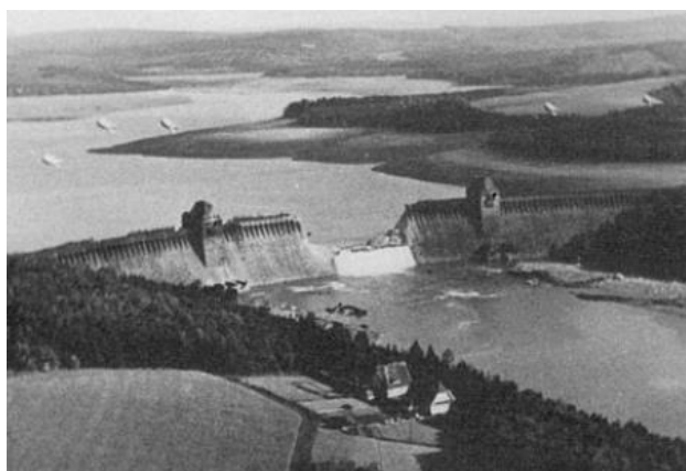
Figura 20 – Ruptura da barragem Mohne, Alemanha. DOUGLAS 2012.
