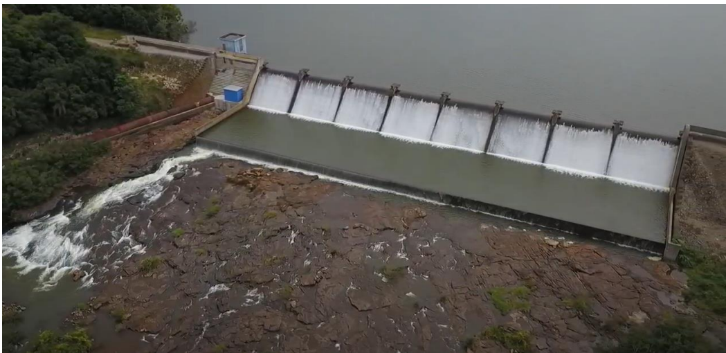
Figura 86 – Foto aérea da barragem de Ernestina. Fonte: Fraga, 2022.
