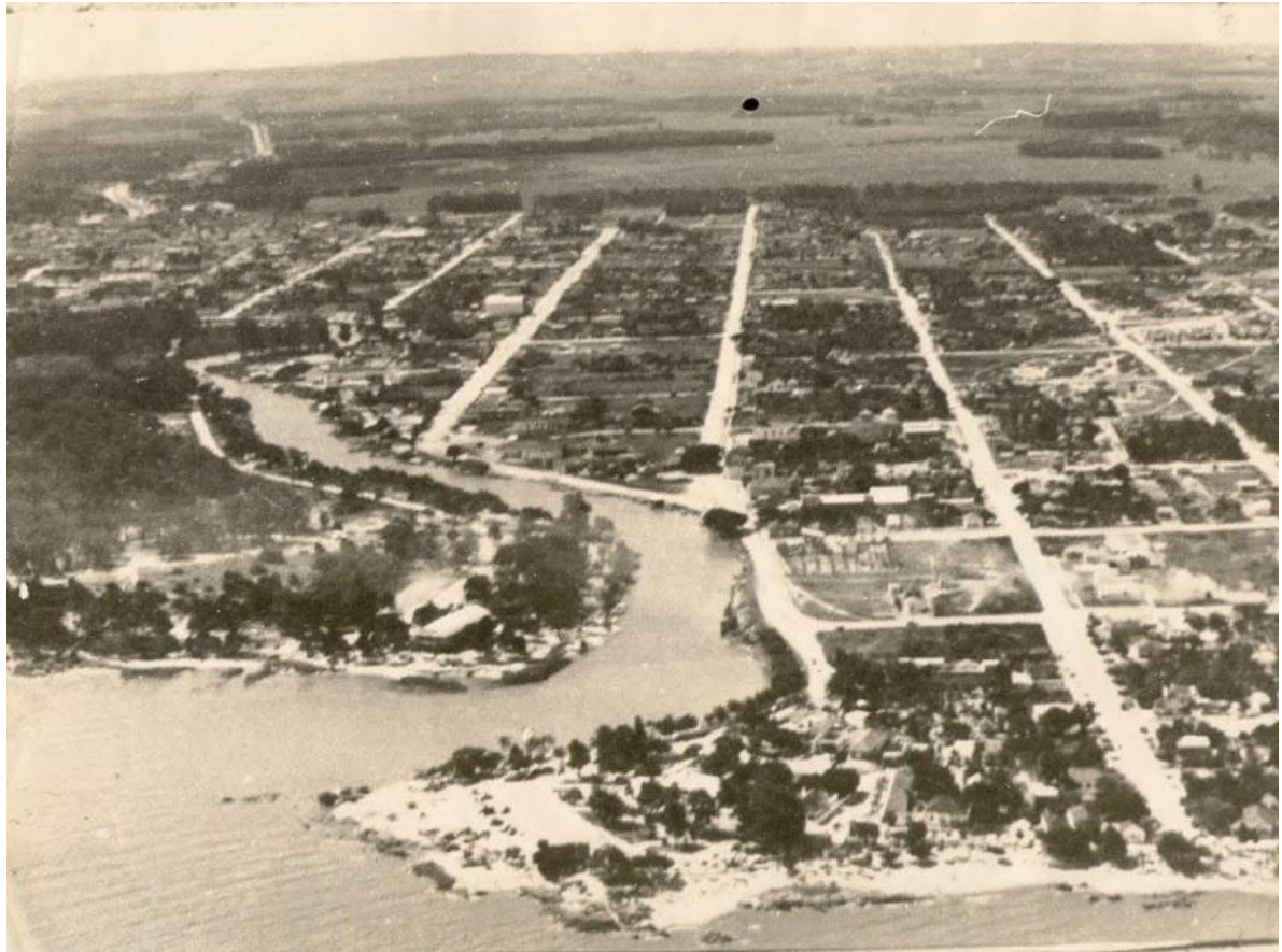
Figura 3 – Arroio São Lourenço.
