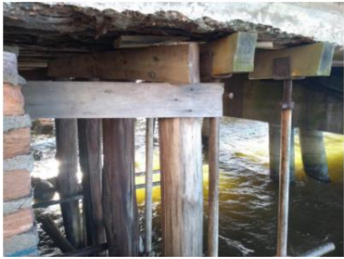
Figura 13 - Escoramento do primeiro vão (CARDOSO, 2018)
