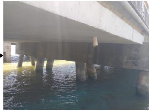
Figura 14 - Primeiro vão após reforma (Autor, 2022)
