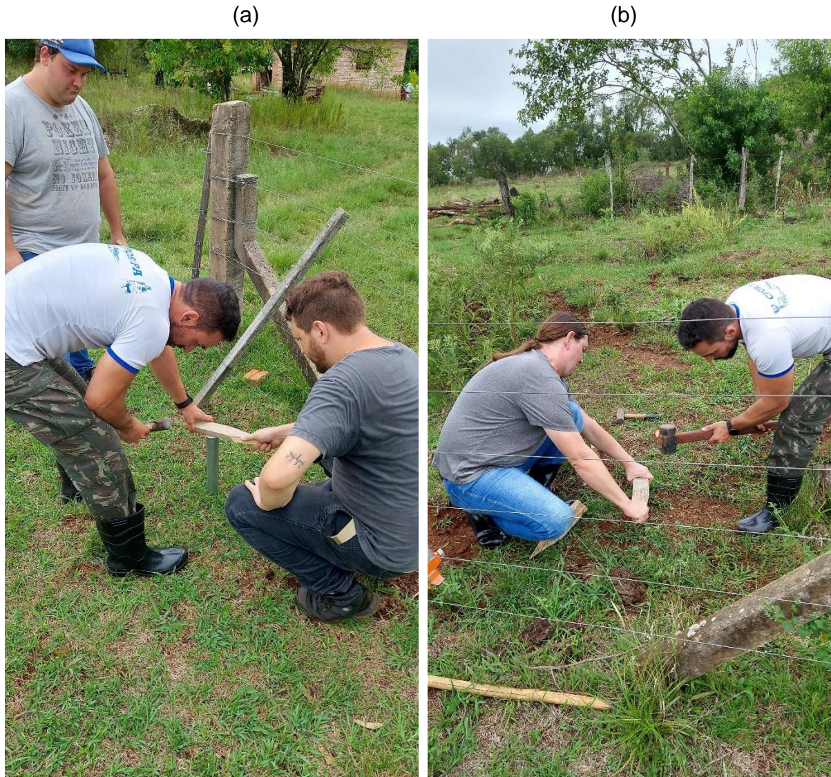
Figura 19 – Instalação dos marcos de aço galvanizado. Em (a) Marco M001, em (b) Marco M002
