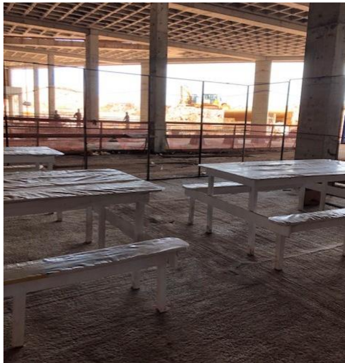
Figura 17 - Refeitório locado no pavimento térreo, com aproveitamento da iluminação natural
