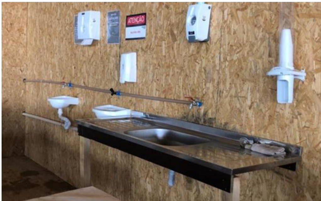
Figura 16 - Sistema de reaproveitamento de água nos refeitórios
