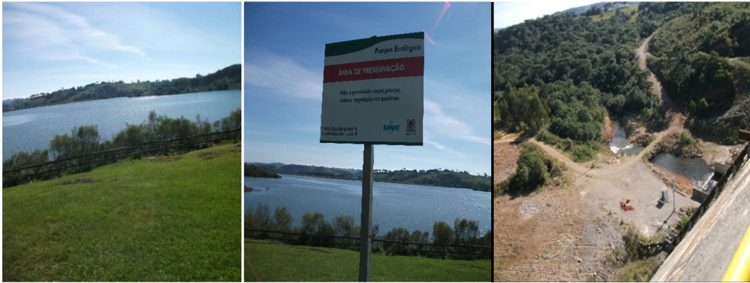
Barragem Marrecas, acervo dos autores, 2016.
