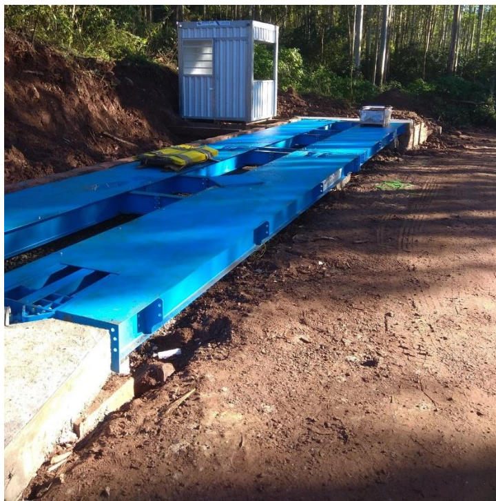
Figura 33 – Balança em fase de instalação, em julho de 2019
