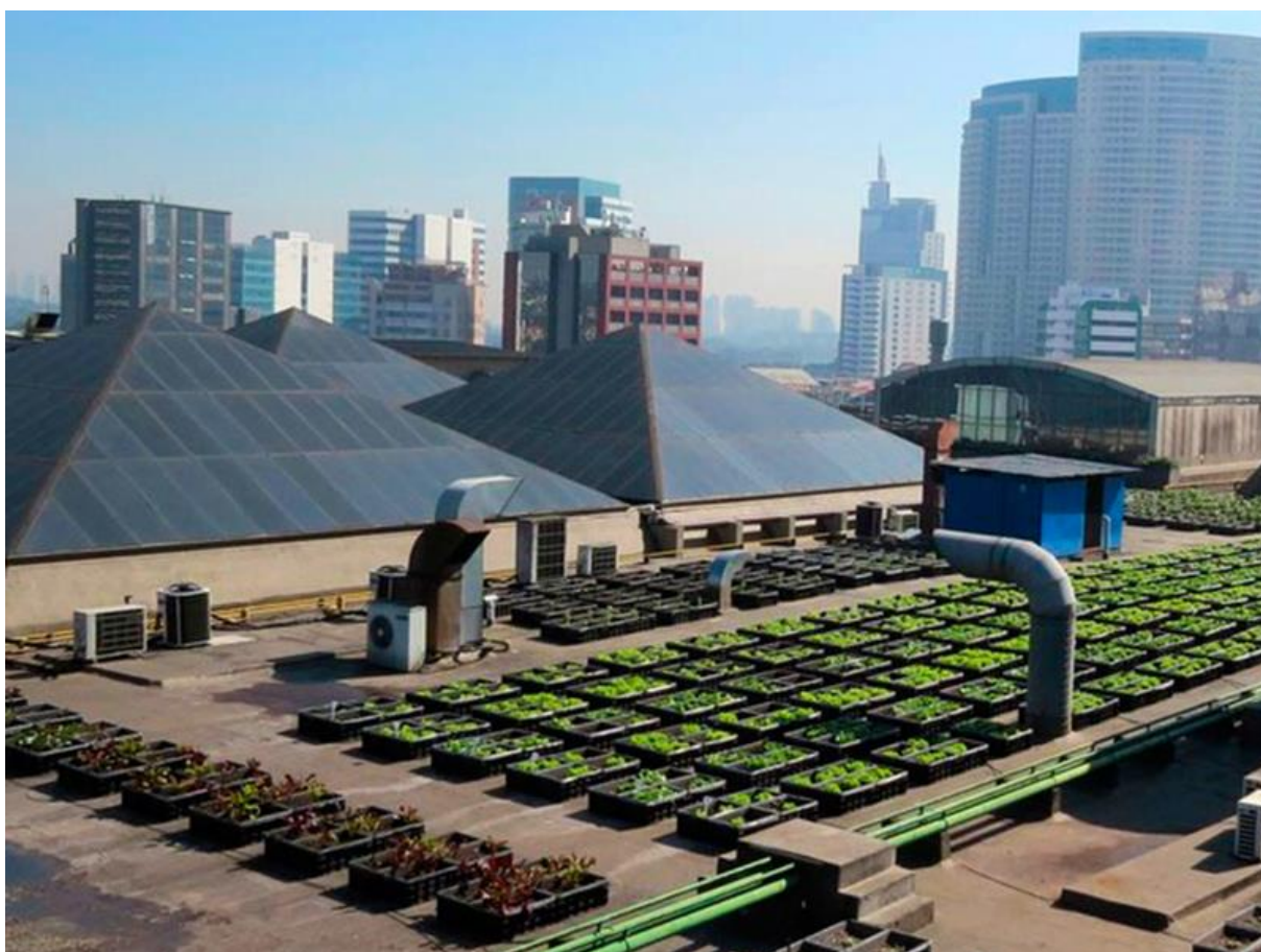
Figura 15 – Telhado verde, onde foi aplicado um processo de compostagem: Shopping Eldorado, em São Paulo,
