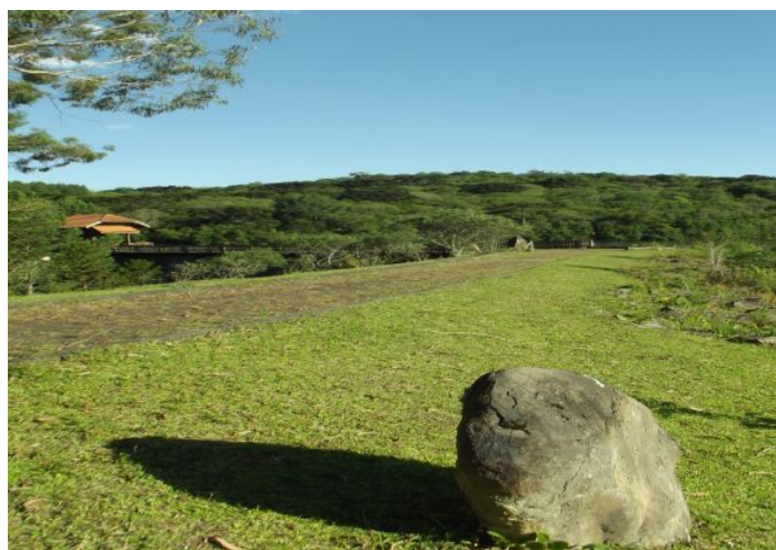
Figura 18: Caminho de acesso à barragem ao longo de um dique. Fonte: Mariana Belotto (2021)
