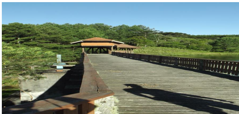
Figura 20: Deck/ caminho para barragem. Fonte: autora (2021).
