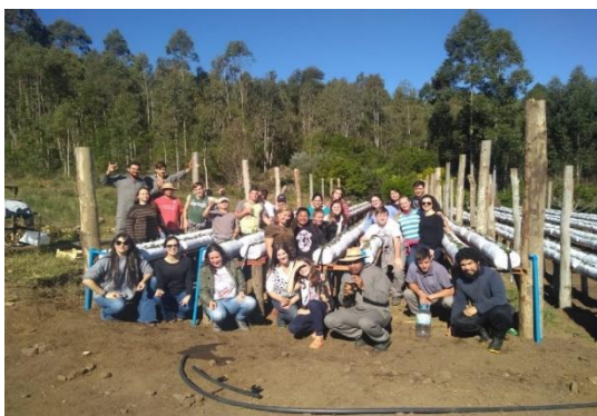
Figura 3 – Mutirão na propriedade da família de um educando, para instalação de sistema de irrigação.
