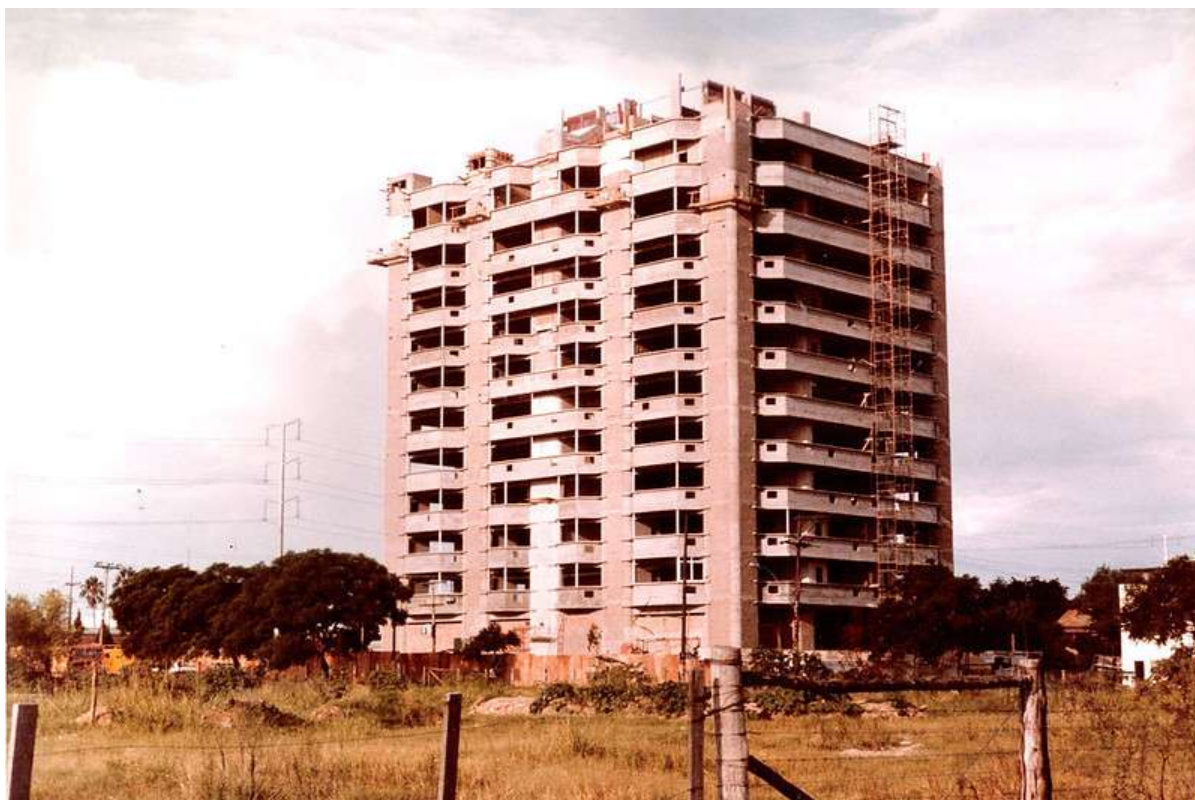
Figura 15 – Obra de construção do edifício do TRT4 Fonte: TRT4
