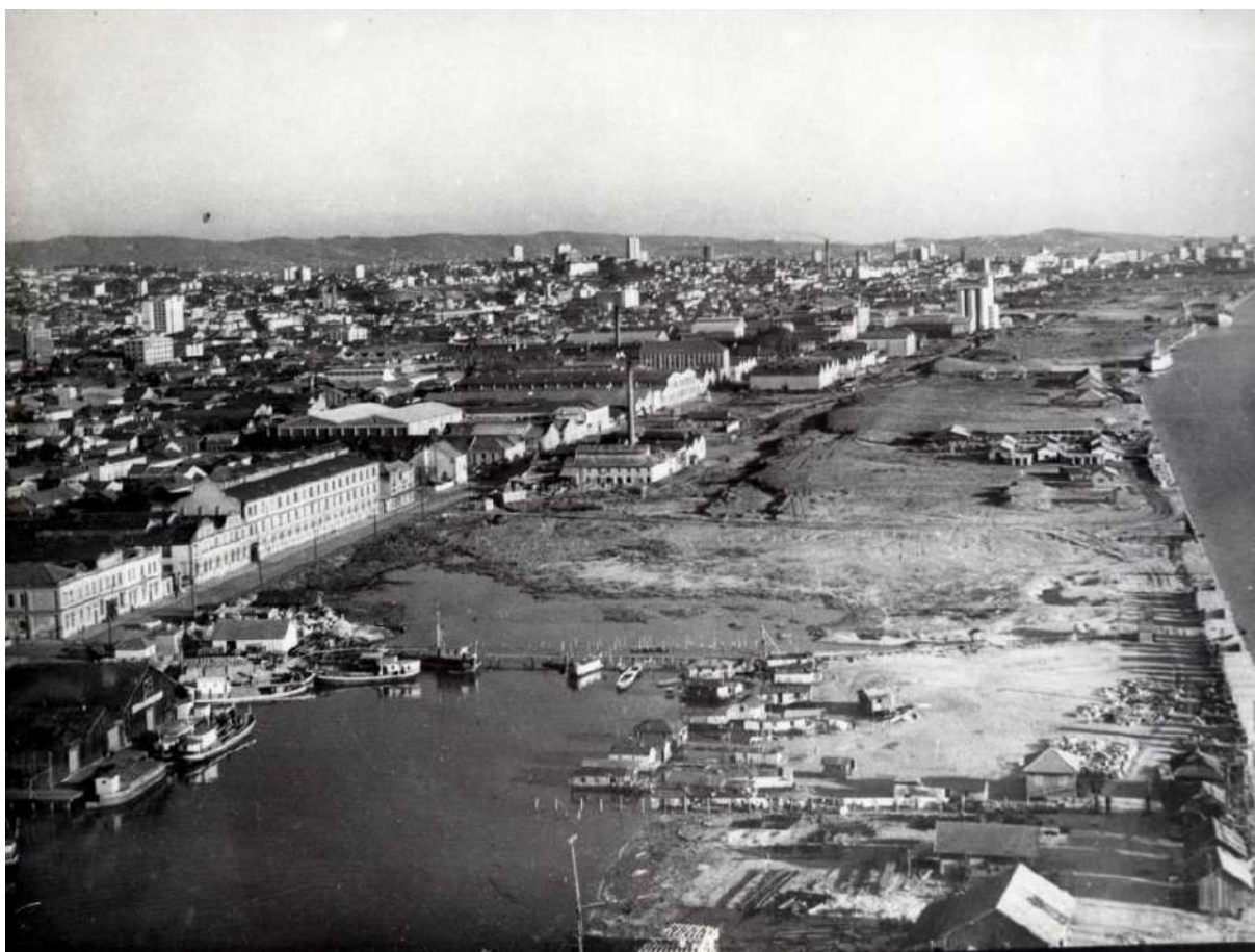
Figura 3 – Construção do aterro na altura da Rua Voluntários da Pátria (1955)
