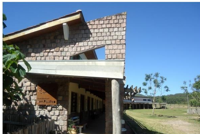
Figura 2. Faixada da escola.
