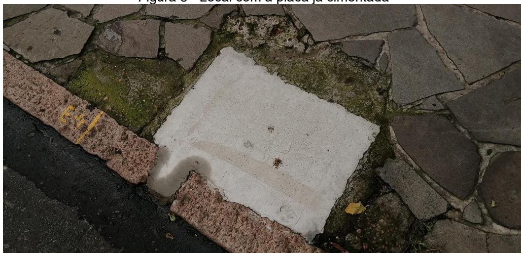
Figura 8 - Local com a placa já cimentada
