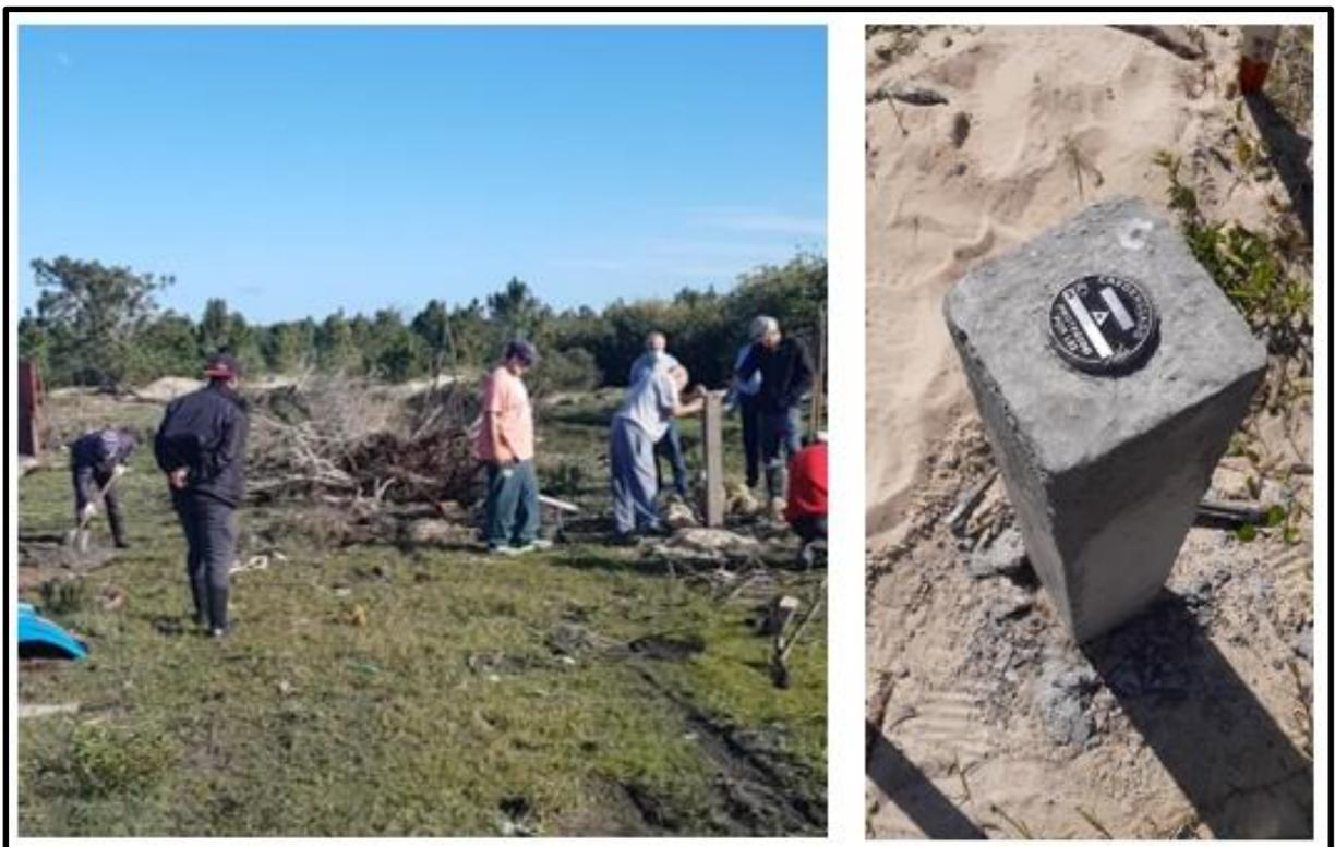
*Figura 17 – Instalação dos marcos geodésicos*
