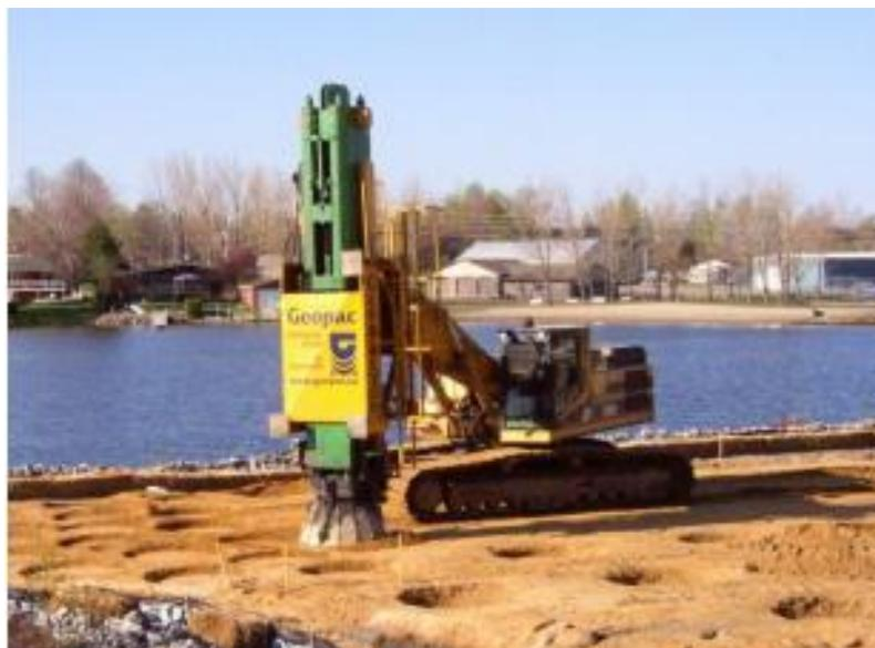
**Figura 35** – Equipamento sobre esteiras de compactação – RIC. (Fonte: Lauzon *et al.*, 2011)
