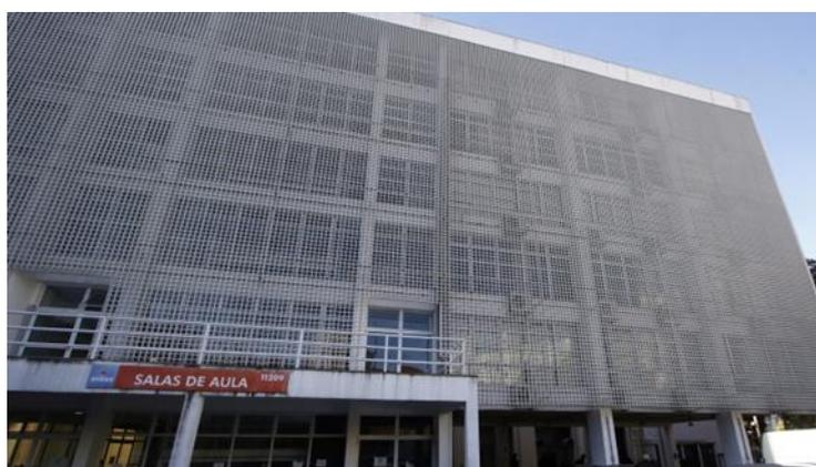
Figura 11: Ilustração da instalação de um brise. Fonte: UFRGS, 2021
