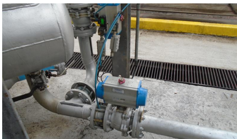
Figura 6 – Válvula de gaveta pneumática
