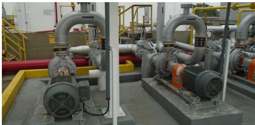
Figura 7 – Montagem da bomba no sistema
