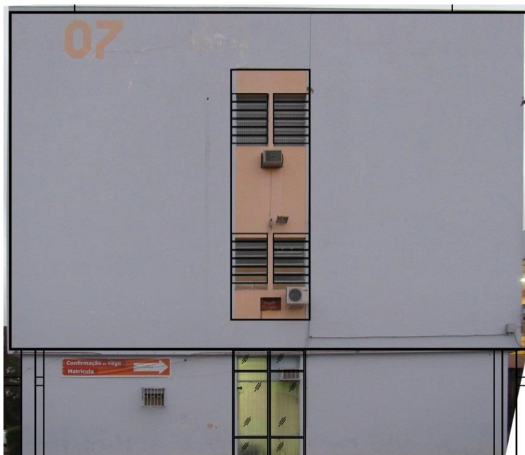
Figura 55 – Exemplo da montagem e planificação da fachada leste do Centro de Tecnologia, prédio 07, da UFSM
