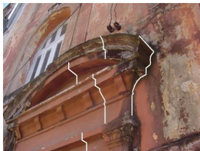
Figura 17 - Detalhes que descolam ou conduzem a água para fachada
