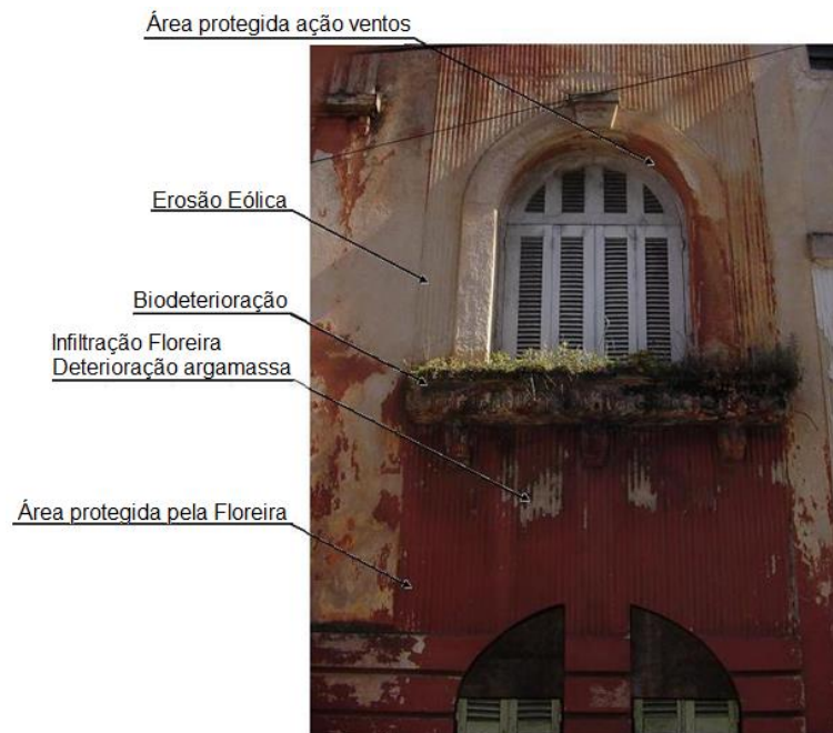
Figura 16 – Influência dos detalhes construtivos na preservação das fachadas
